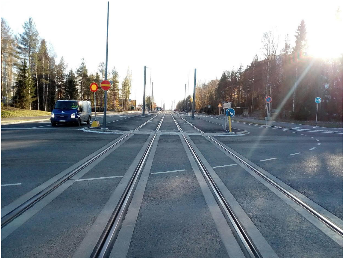
KUVA 2. Insinöörinkadun alkuosa Tampereen Hervannassa (Raitiotieallianssi 2018)
