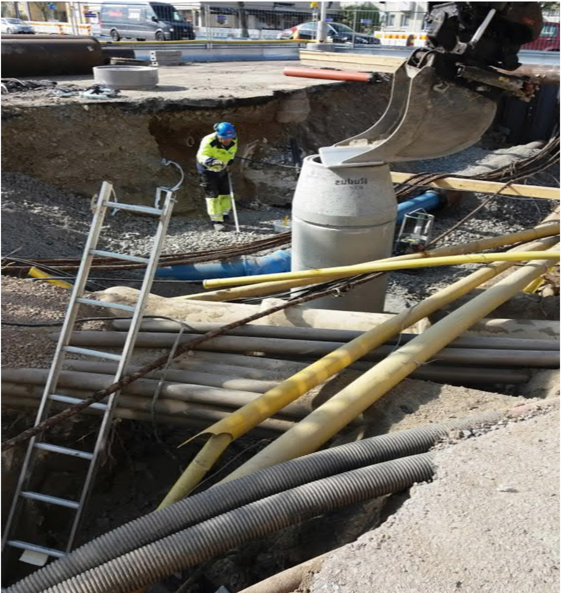
KUVA 4. Työskentelyä putki- ja johtolinjojen keskellä. (Raitiotieallianssi 2017)
