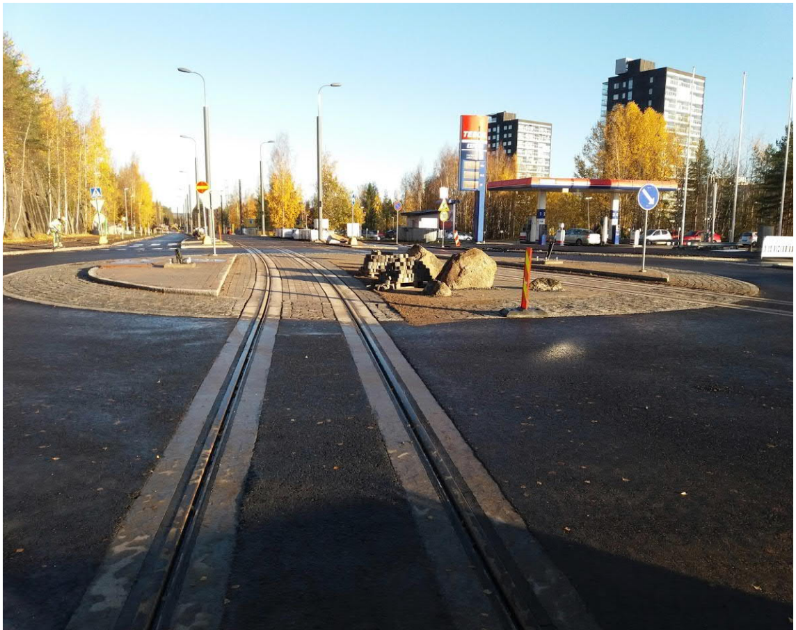
KUVA 3. Kiertoliittymä, jonka läpi raitiotie kulkee (Raitiotieallianssi 2018)
