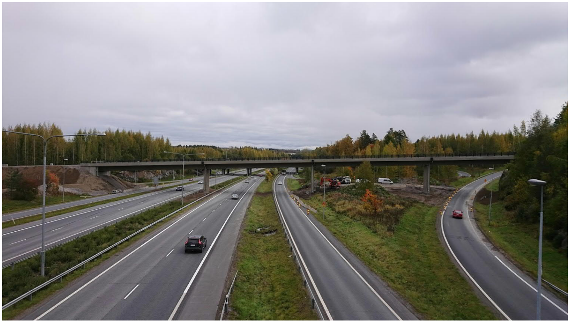
KUVA 11. Tampereen kehätien ylittävä raitiotiesilta (Raitiotieallianssi 2018)
