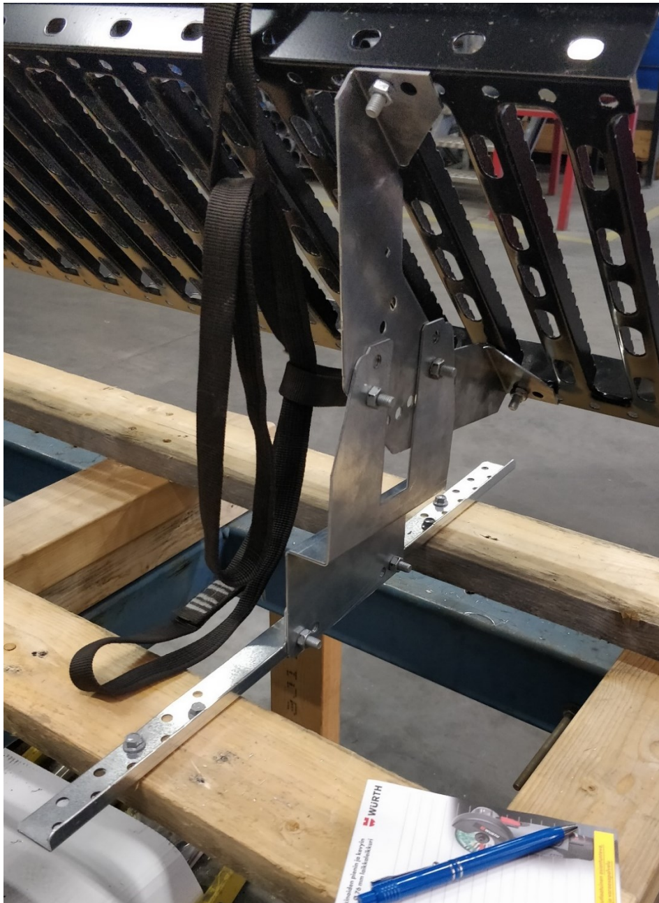
Kuva 19. TKL3:n asennus vetokoetta varten
