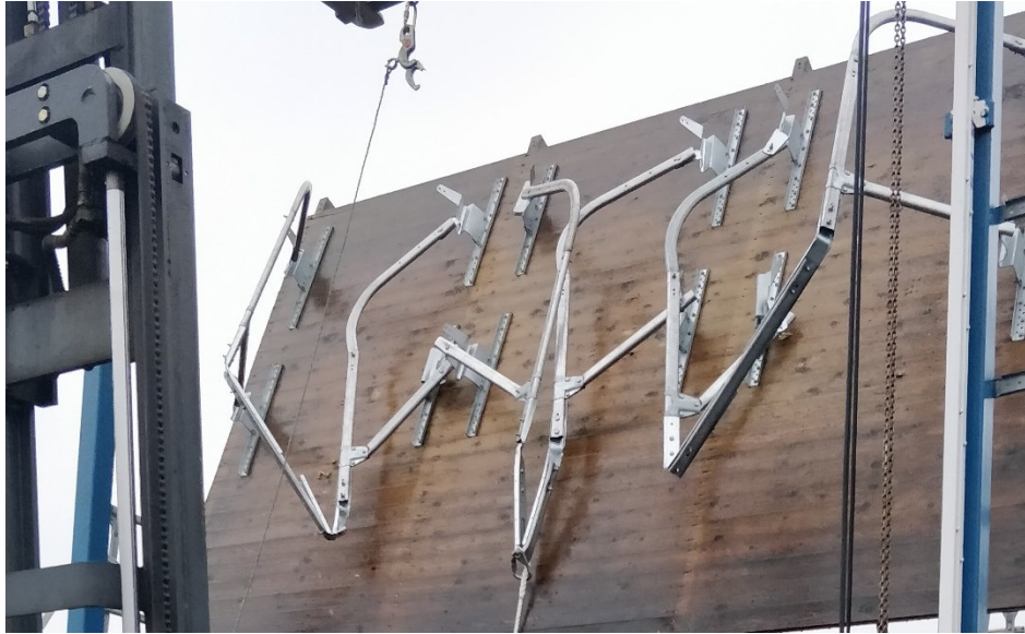
Kuva 53. TKL3 kattoluukunkaiteet tiputuskokeiden jälkeen
