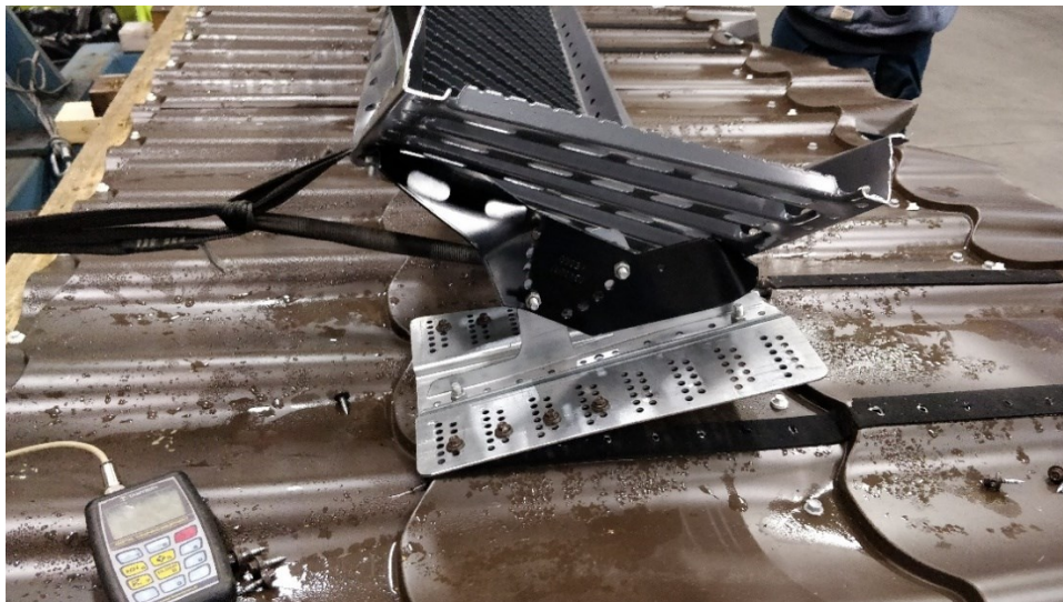
Kuva 64. Muotokaton kattosilta vedon jälkeen
