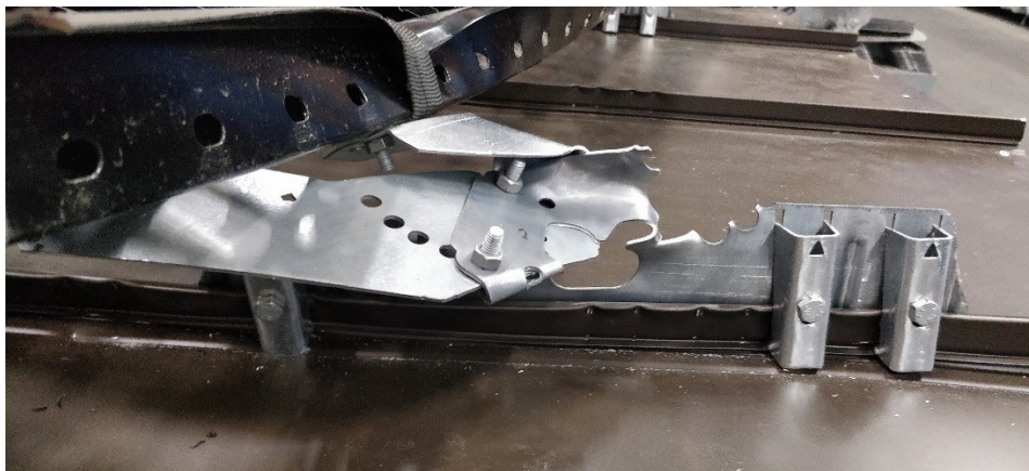
Kuva 59. Lukkosauma kattosiltakokoonpano 2.02 mallin kannakkeella
