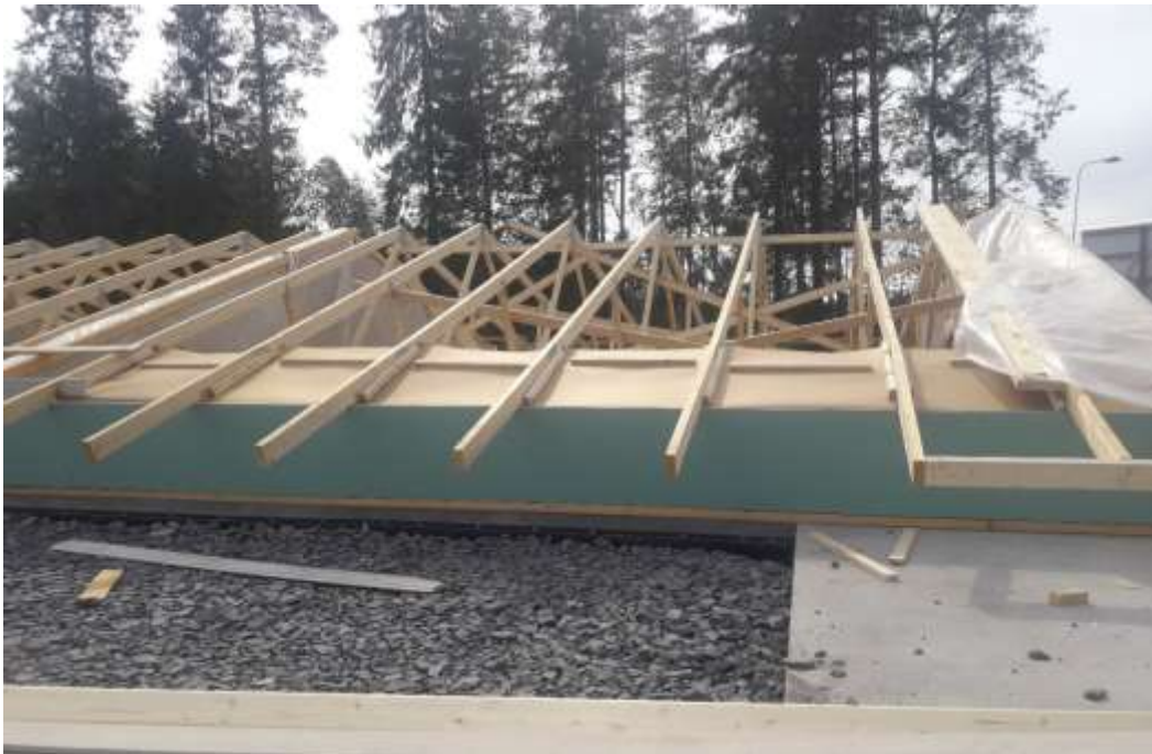
KUVA 6. Tuulensuojalevyt ja tuulenohjaimet asennettuna paikoilleen
