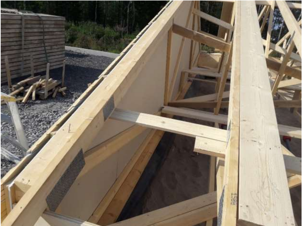
KUVA 3. Ensimmäinen ristikko kiinnitettynä päätyelementtiin
