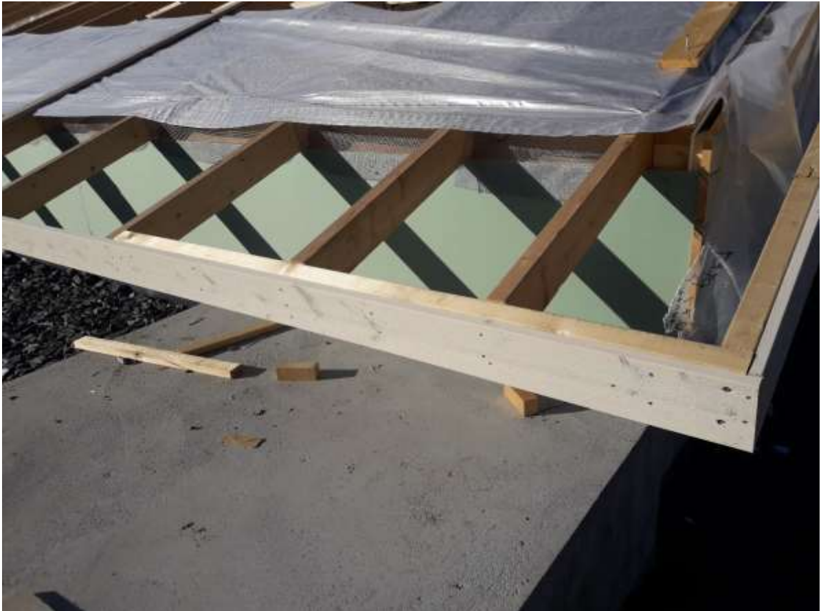
KUVA 7. Päätyräystään tukilankku ja otsalaudat
