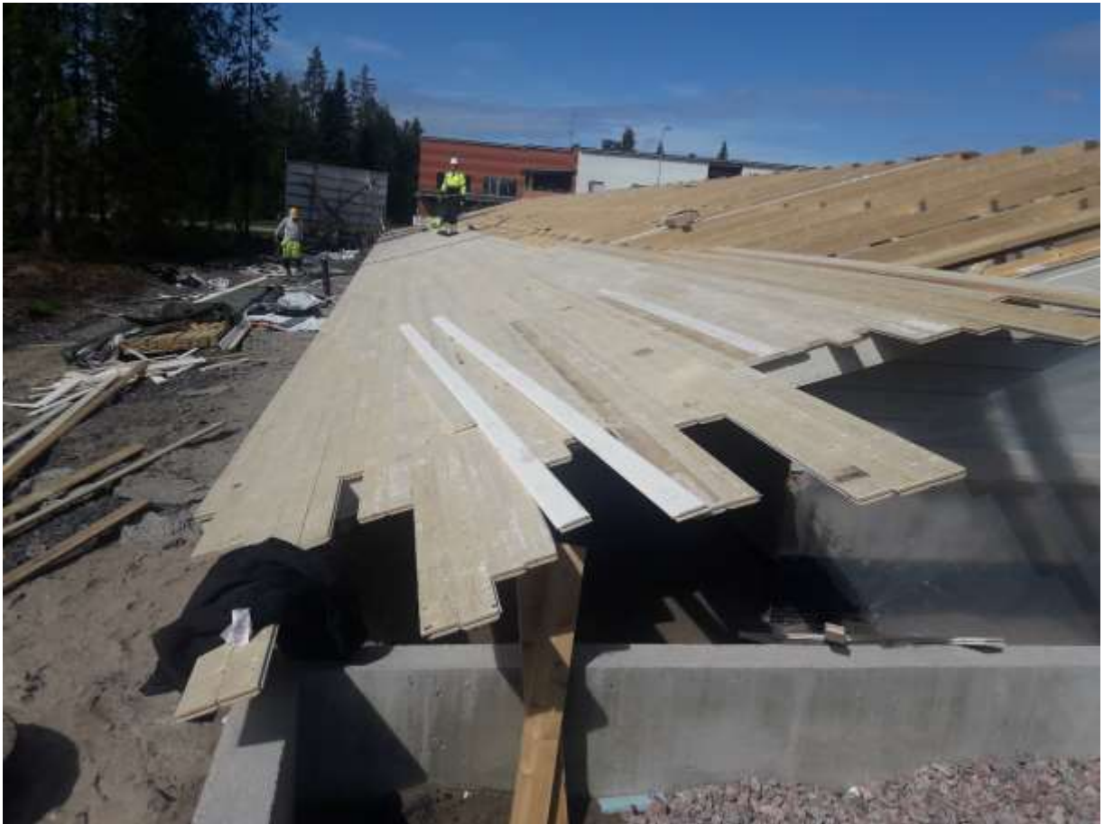
KUVA 8. Raakaponttilaudoituksen tekeminen
