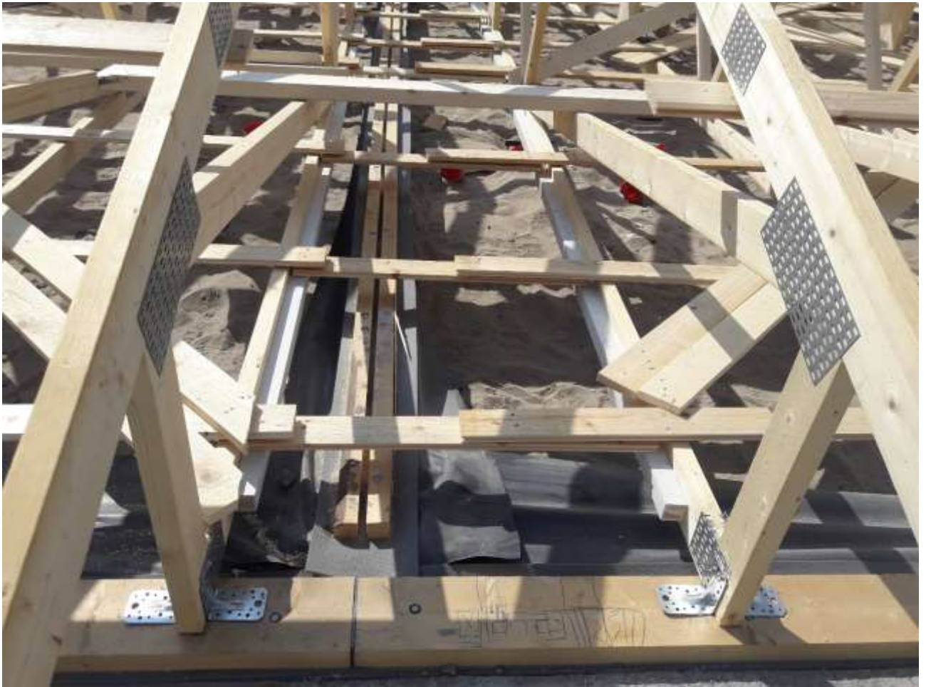
KUVA 4. HV-seinän kohdalla tehty koroke palokatkoelementille
