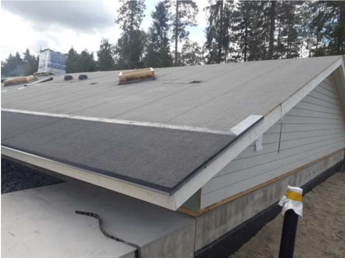
KUVA 11. Ensimmäinen huopakaista asennettuna
