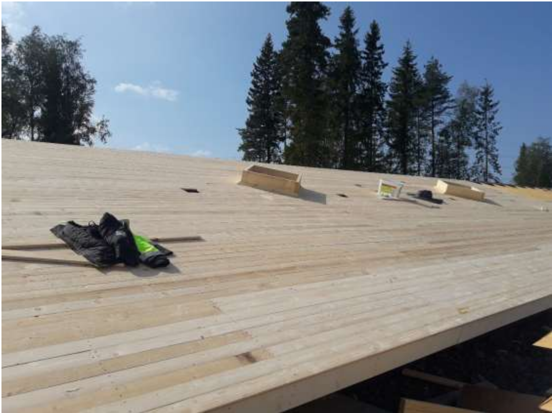
KUVA 9. Kattoluukut paikalleen asennettuna, läpivienti- ja nostoaukot tehtynä
