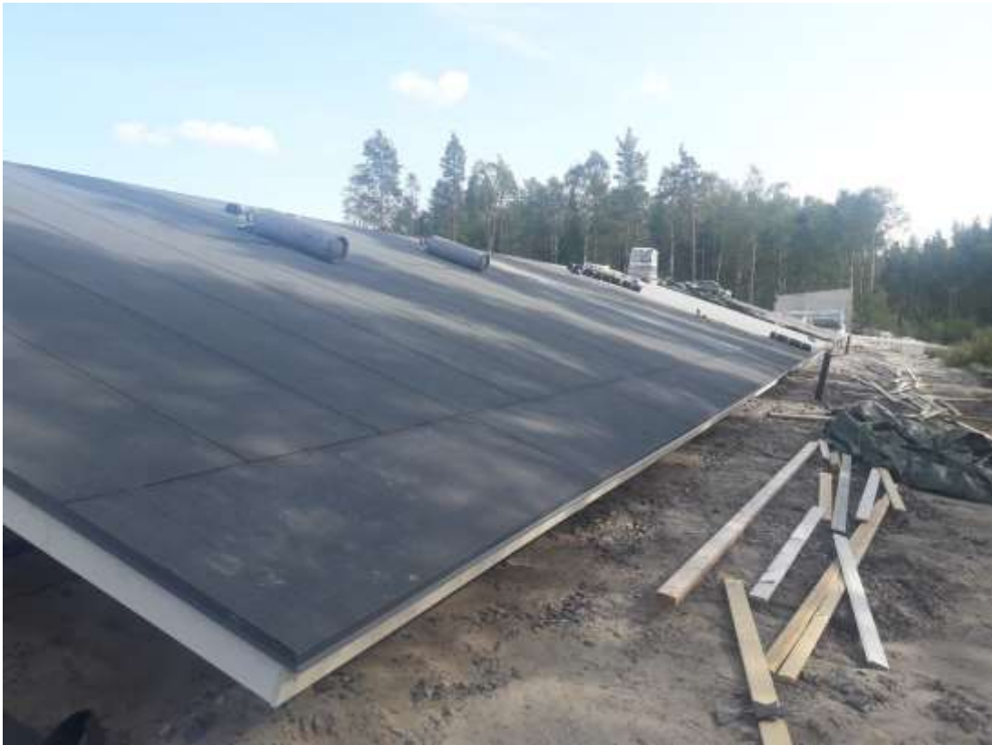
KUVA 12. Pinta-huopa asennettuna
