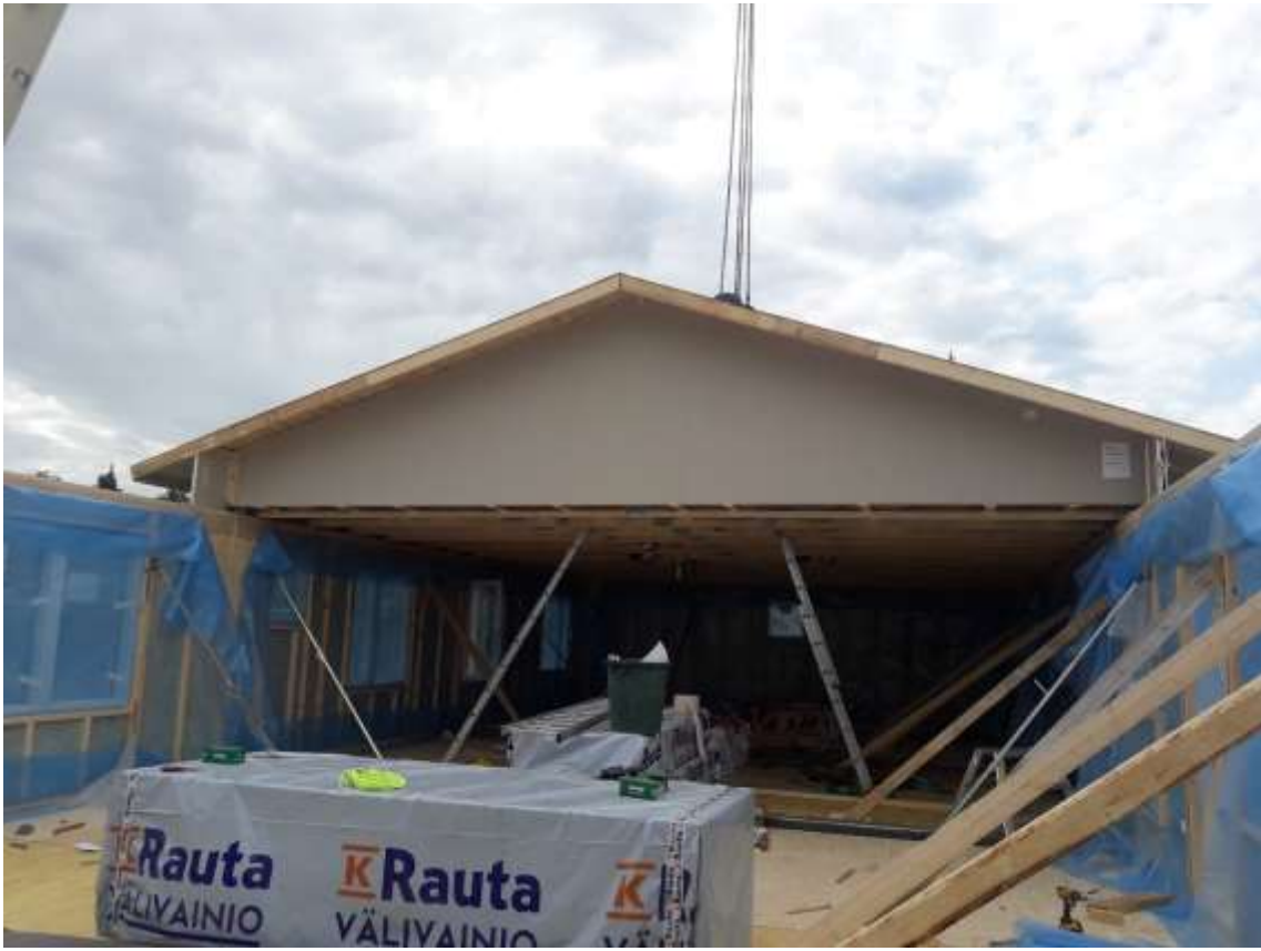
KUVA 14. Kattoelementin paikoilleen asennus
