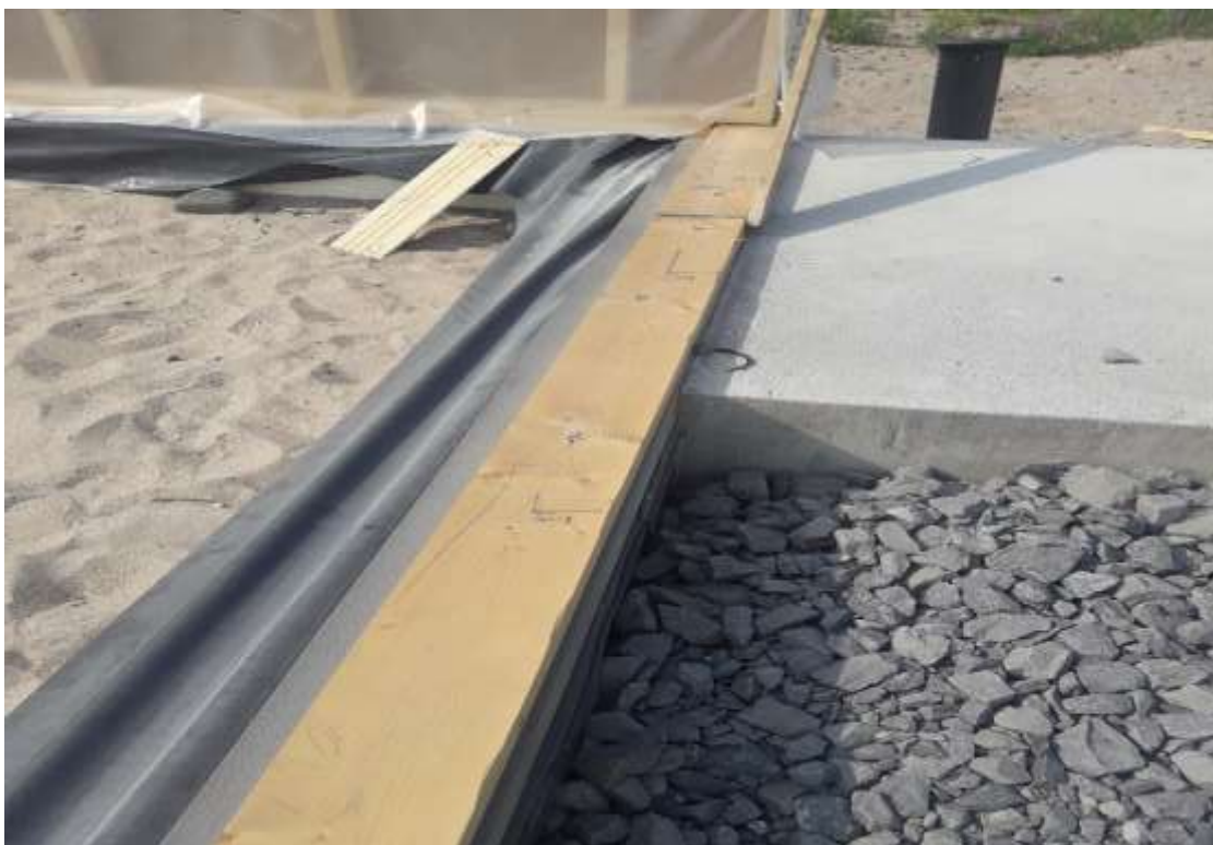
KUVA 1. Alaohjauspuuhun merkitty ristikkojako, joita vasten ristikot voidaan asettaa
