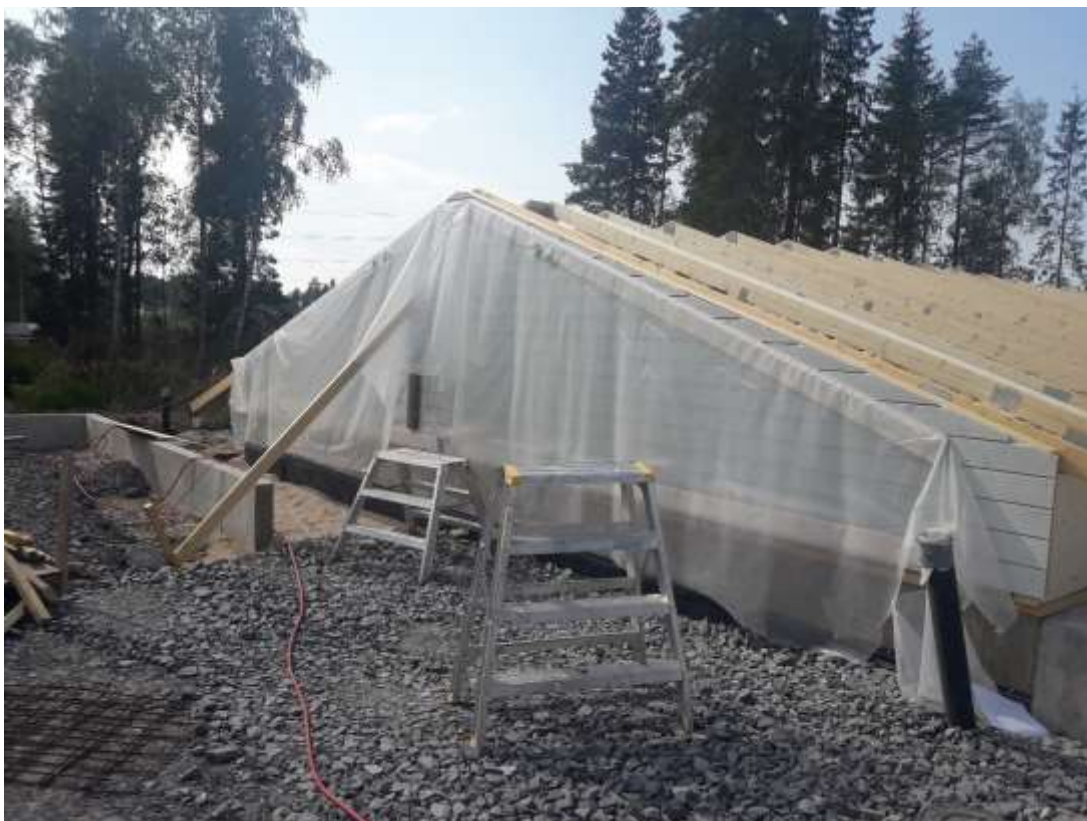
KUVA 2. Päätykolmio asennettuna ja tuettuna paikoilleen
