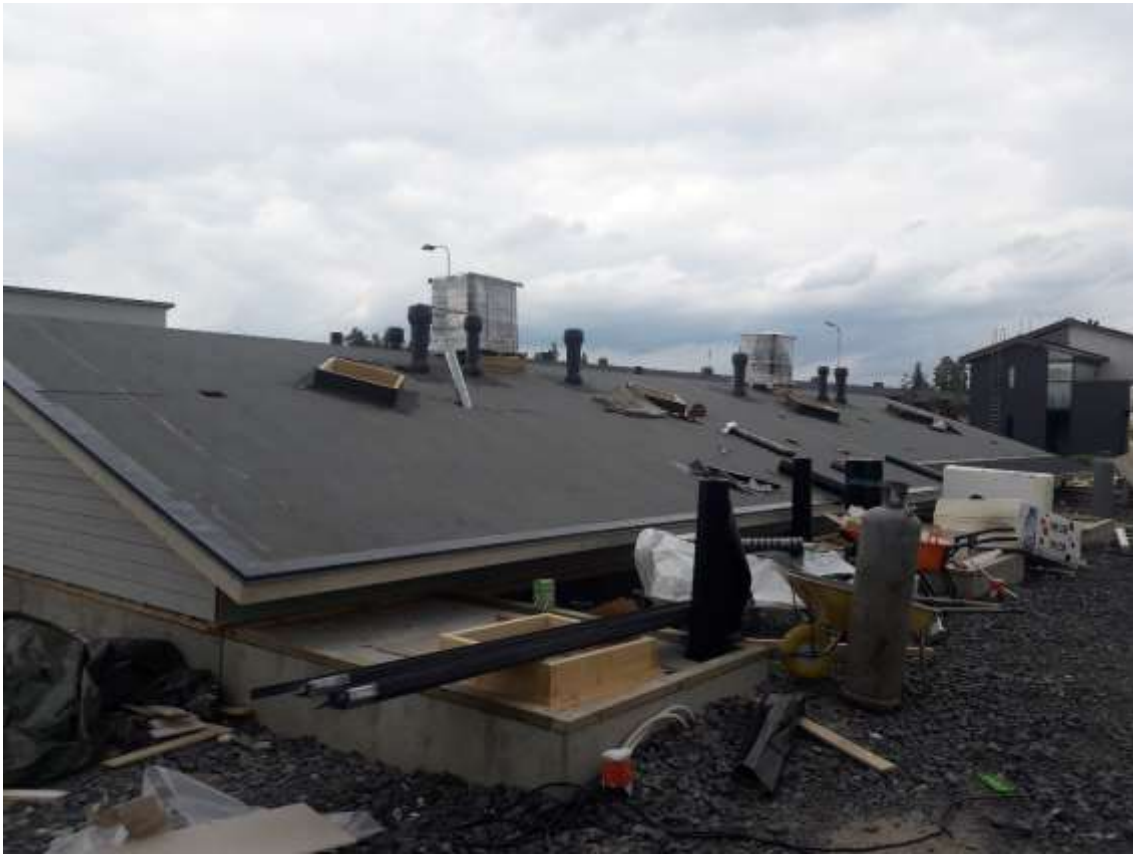
KUVA 10. Alushuopa, räystäspelti ja läpivientilaipat asennettuna. Kattoluukkujen ylösnostot pintahuovalla
