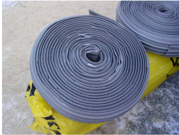
Alaohjauspuun alle asennetaan sokkelikaista
