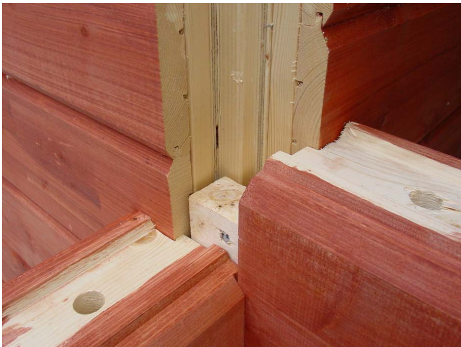
Nurkan kiinnitys ruuveilla ja kierretangoilla
