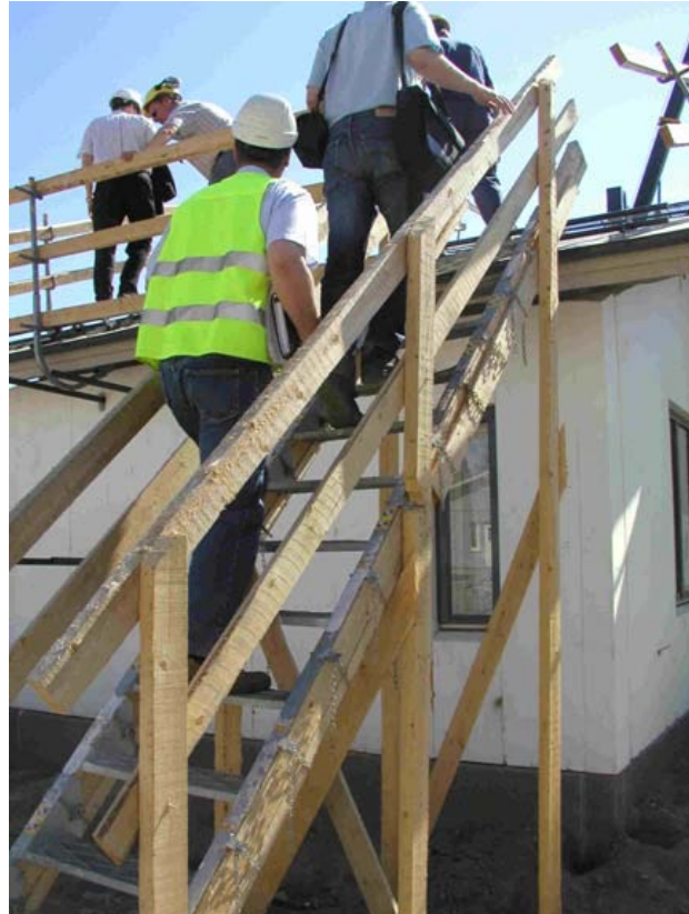
Kuva 4. Asianmukaiset portaat ovat turvallinen kulkutie katolle (Mäkelä/Kauranen)
