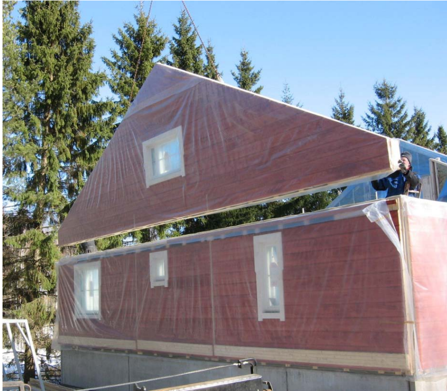
Päätyelementin nosto paikoilleen
