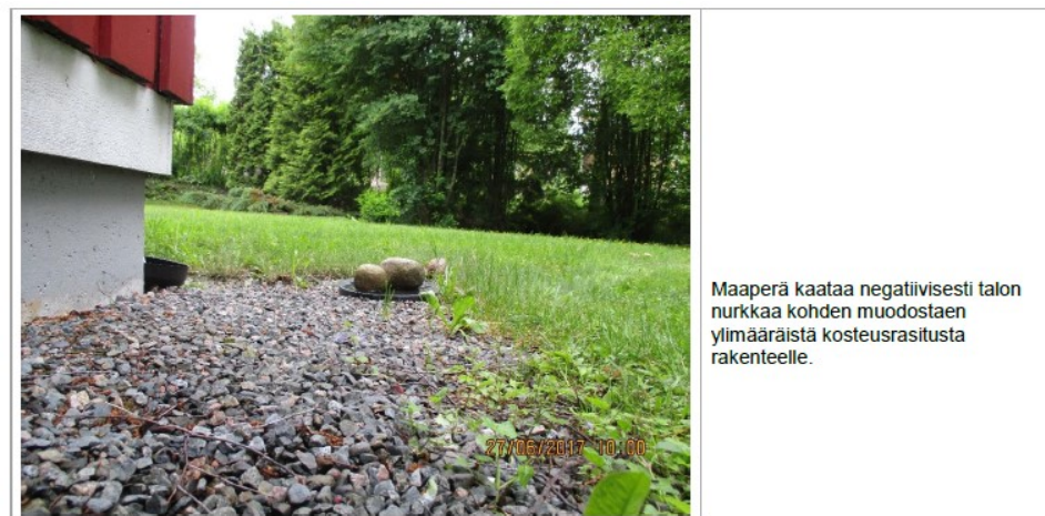
Kuva 20. Perusmaan kosteusrasitus sokkelissa (Materiaaliarkisto, Pulkkinen).
