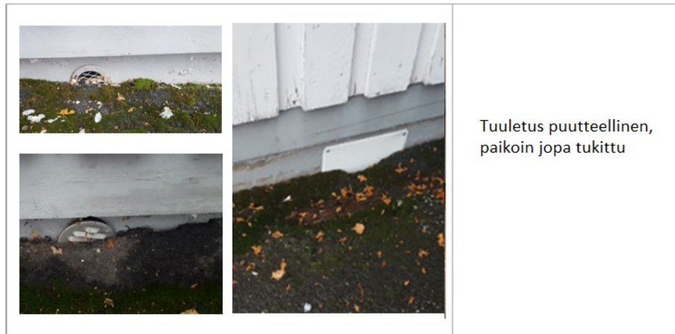
Kuva 21. Tuuletusaukot (Materiaaliarkisto, Pulkkinen).
