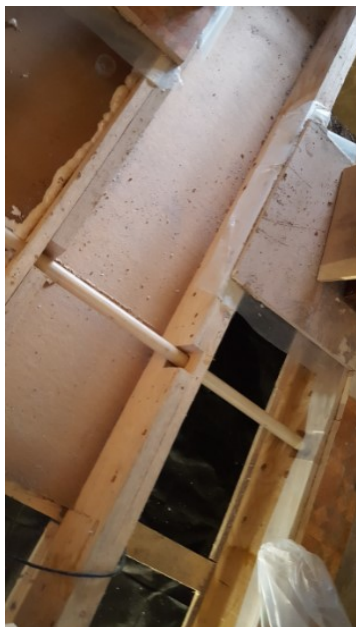
Kuva 35. Lattian jälleenrakentaminen (Materiaaliarkisto, Pulkkinen).
