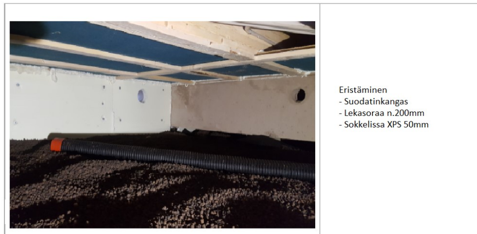
Kuva 29. Alapohjan eristäminen (Materiaaliarkisto, Pulkkinen).
