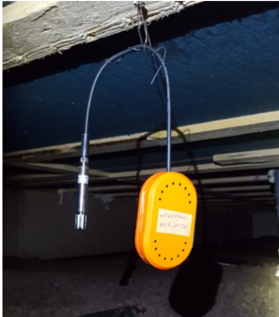
Kuva 39. Anturit alapohjassa (Materiaaliarkisto, Pulkkinen).
