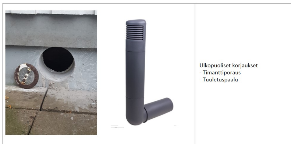
Kuva 30. Ilmanvaihdon parantaminen (Materiaaliarkisto, Pulkkinen).
