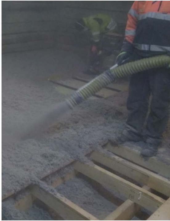
Kuva 36. Puhallusvillan asentaminen (Materiaaliarkisto, Pulkkinen).
