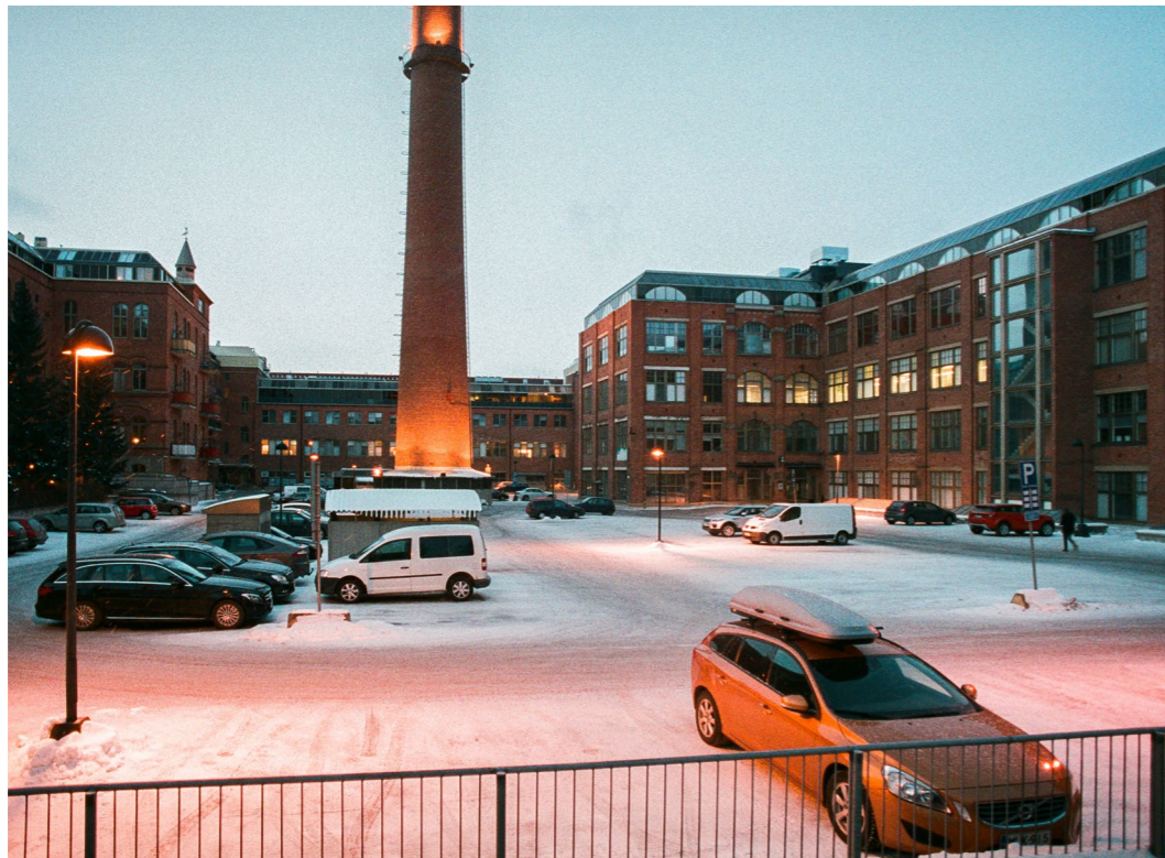
Kuva 12. Näkymä kadulta sisäpihalle.
