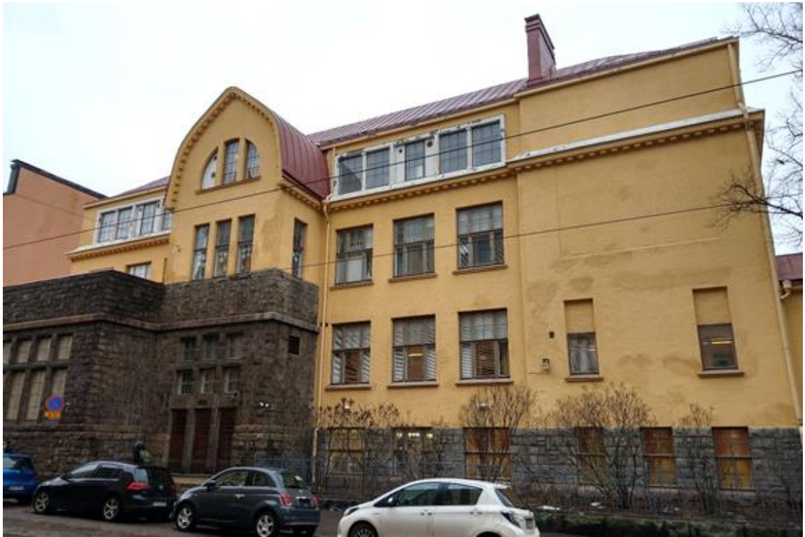
Kuva 20. Tehtaankadun ala-asteen julkisivu Tehtaankadulle.
