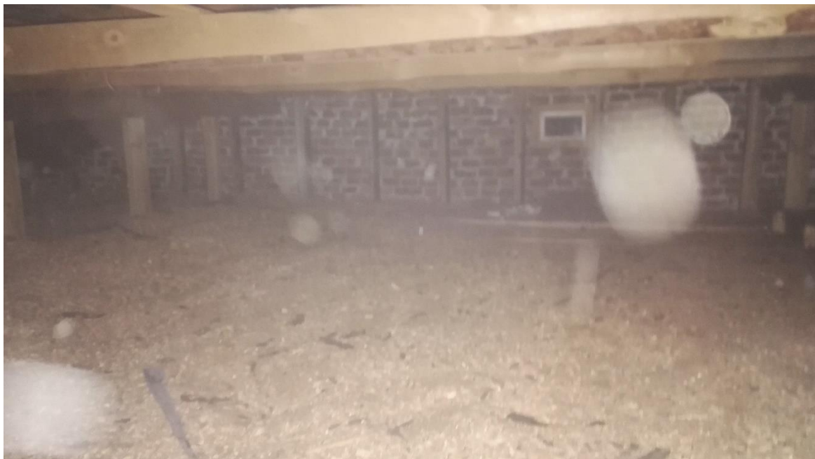
Kuva 8 Kohteen yläpohja (Kokki, 2018)
