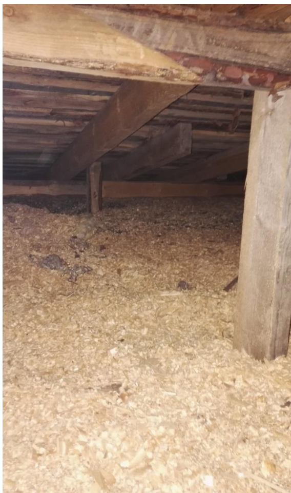
Kuva 7 Kohteen yläpohja pitkältä sivulta (Kokki, 2018)
