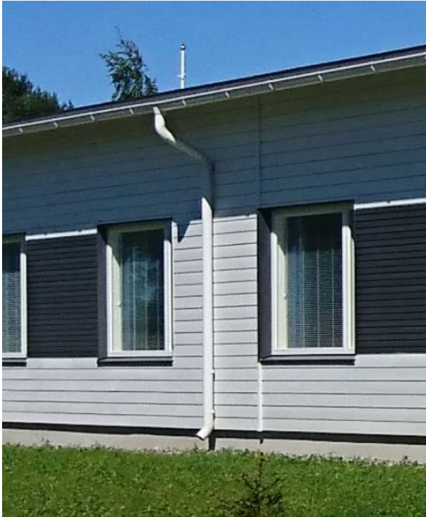
KUVA 41. Elementtisauman sijoittelu syöksytorven nähden
