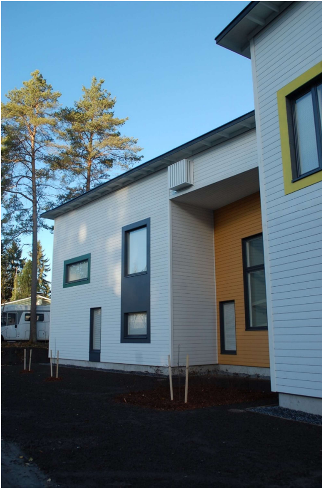
KUVA 10. Vaneri julkisivun pinnassa
