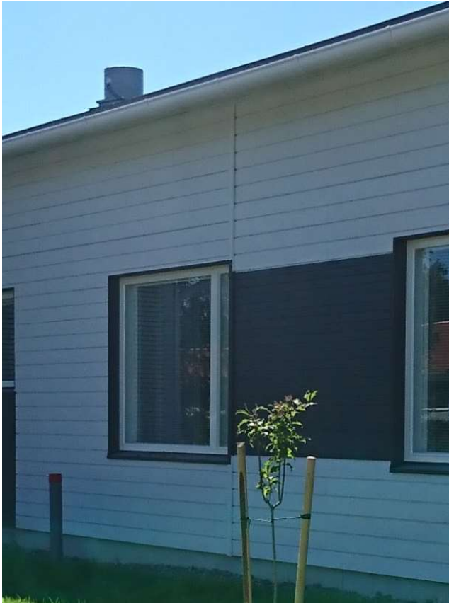
KUVA 11. Elementin pystysauma ikkunan reunassa
