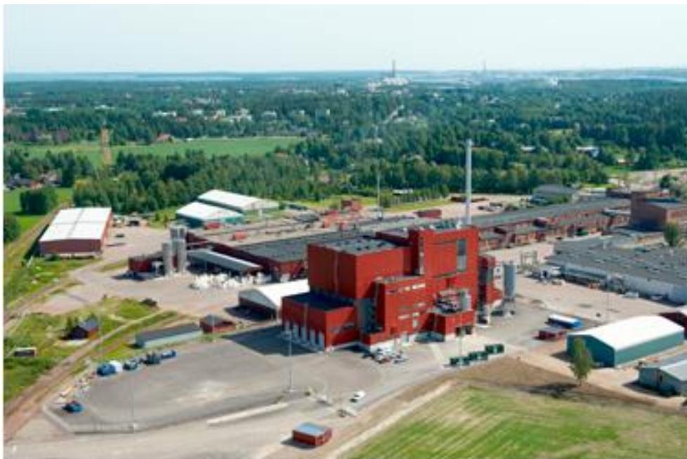
Kuva 4. Kotkan Energian Hyötyvoimalaitos (Kotkan Energia Oy 2018)
