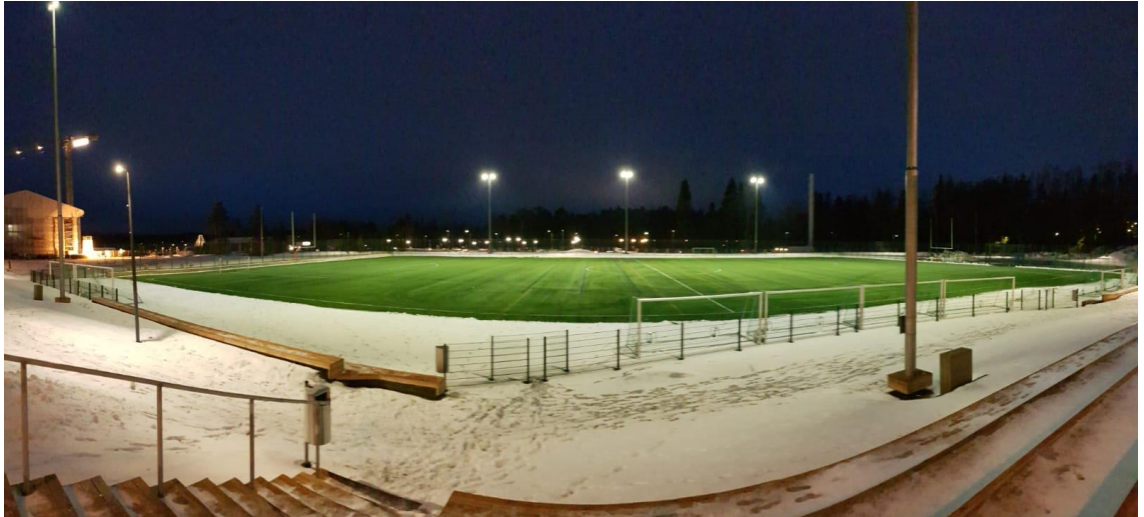
Kuva 32. Söderkullan kentän uusi lediheitinvalaistus. Kuva FCG Suunnittelu ja tekniikka Oy.
