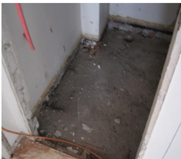
Kuva 3. Kylpyhuoneen lattia on piikattu.
