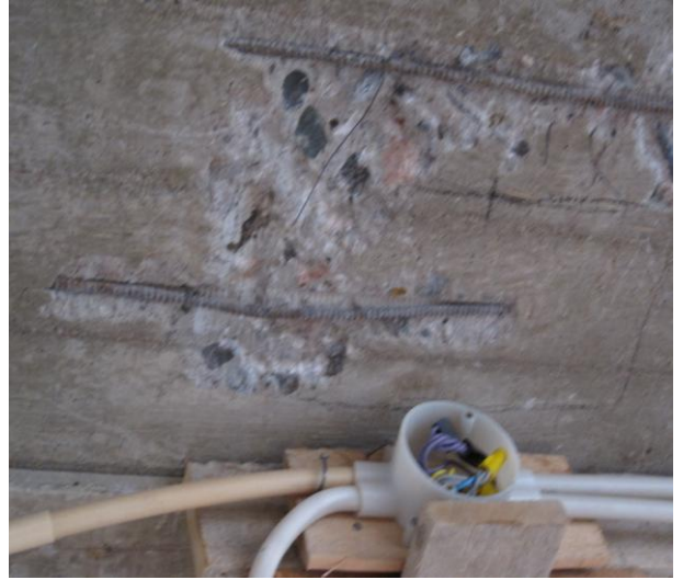
Kuva 2. Raudoitus näkyvässä välipohjalaatassa.
