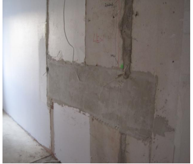
Kuva 14. Keittiön sähköroilot on muurattu.
