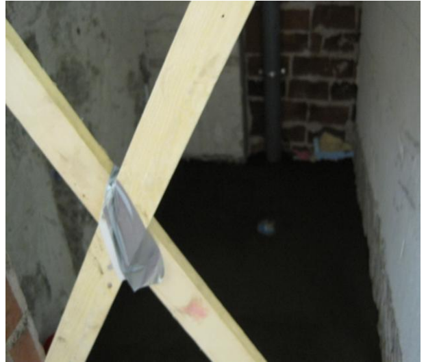
Kuva 8. Vastavalettu kylpyhuoneen lattia.
