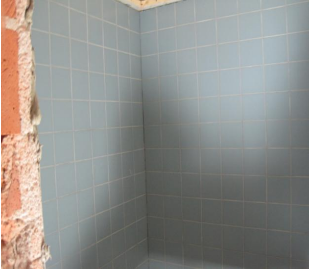
Kuva 13. Valmista seinäpintaa kylpyhuoneessa.
