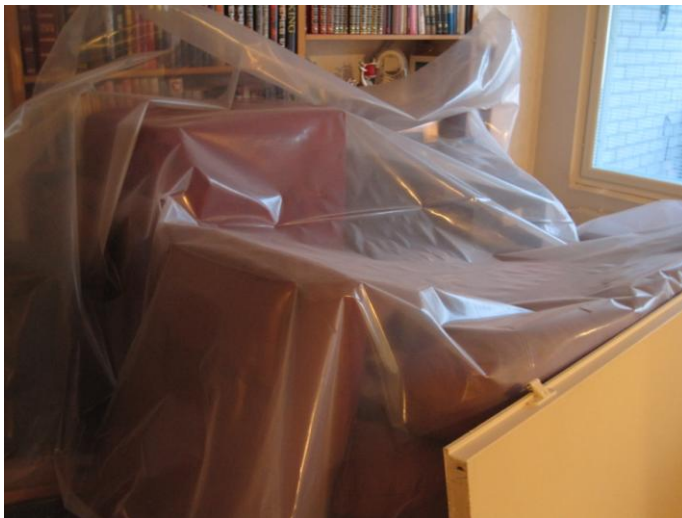
Kuva 14. Kalusteiden suojaus rakennusmuovilla.
