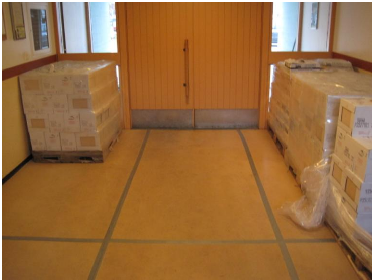
Kuva 12. Lattia suojattu kovalevyillä.
