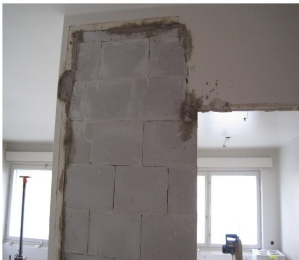
Kuva 1. Muurattu seinä huoneistossa.
