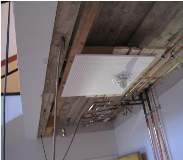
Kuva 7. Kupariputket on uusittu.
