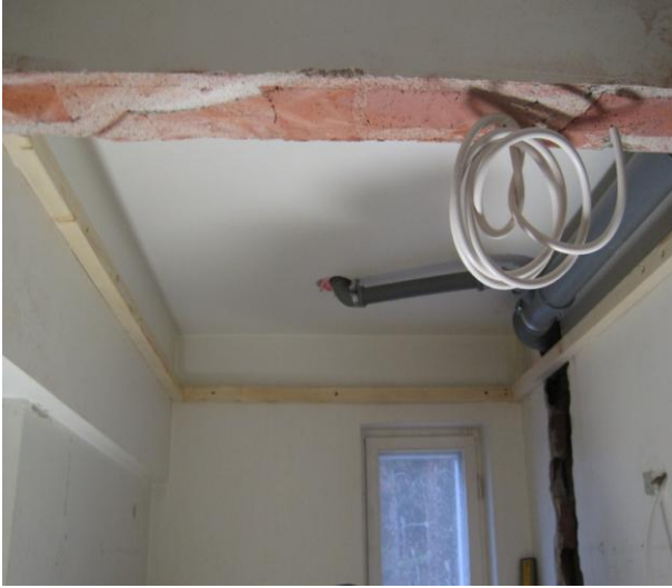
Kuva 5. Alakaton rungon teko on aloitettu.
