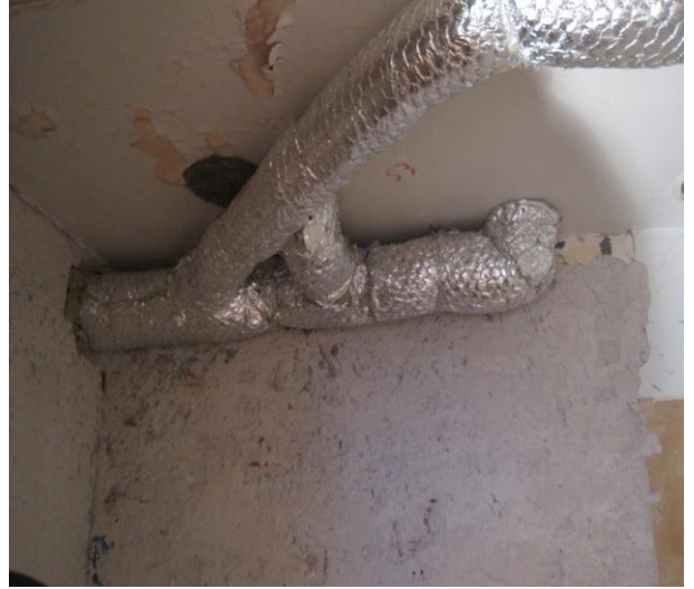
Kuva 10. IV-putket on eristetty.
