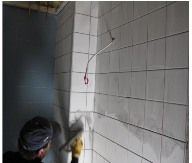
Kuva 12. Kylpyhuoneen laattojen saumaus.
