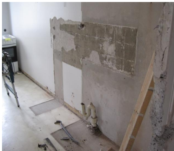
Kuva 2. Keittiökaluusteet on purettu.
