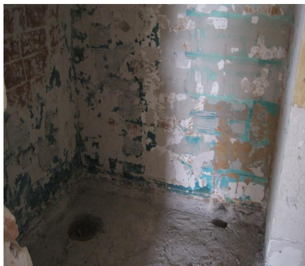
Kuva 4. Kylpyhuoneen laatoitus on purettu.
