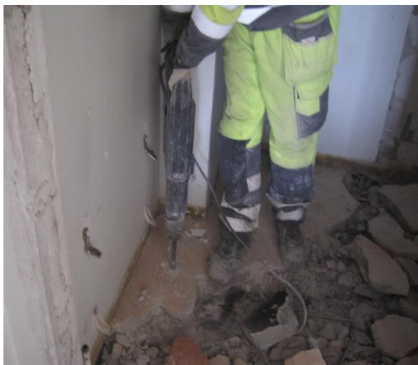
Kuva 5. Kylpyhuoneen lattian piikkausta.
