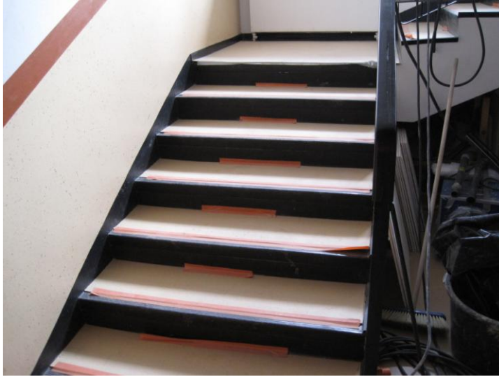
Kuva 13. Porrasaskelmien ja -tasanteiden suojaus kovalevyillä.
