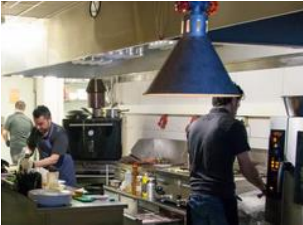
Kuva 18. Puuhiiliuuni on sijoitettu tavallisen huuvan alle [25].
