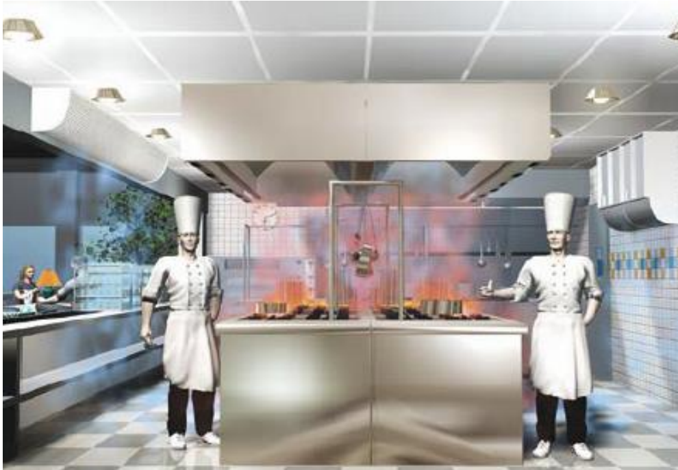
Kuva 2. Syrjäyttävässä ilmanvaihdossa tuloilma tuodaan alhaisella nopeudella huonetilaan. Kuva Haltonin Kitchen Design -oppaasta [8].
