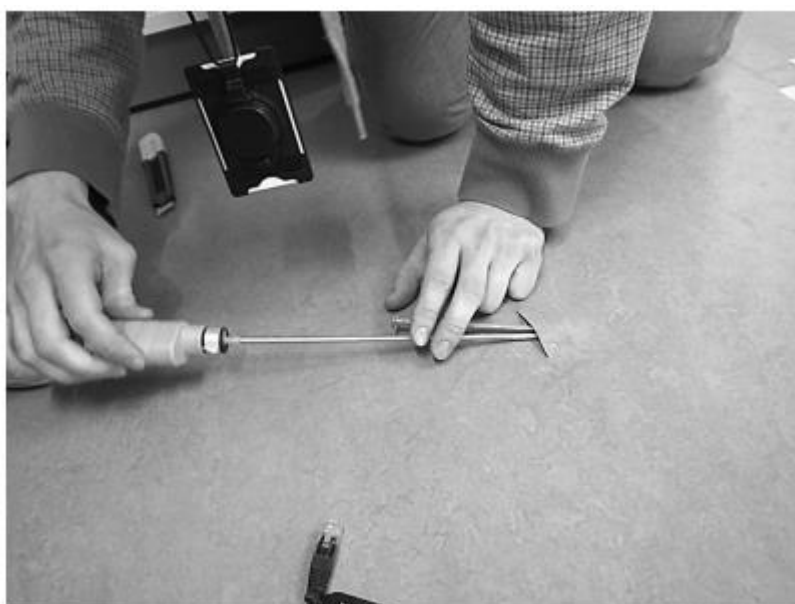
Kuva 10. Lattianpäällysteen alle tehtävä viiltomittaus (Rakennustieto.fi.)
