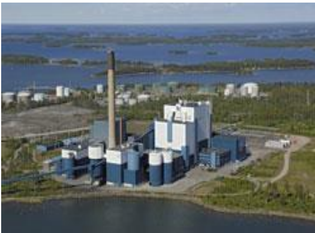
Kuva 1. Meri-Porin voimalaitos. (Pohjolan Voima Oy:n www-sivut 2018.)
