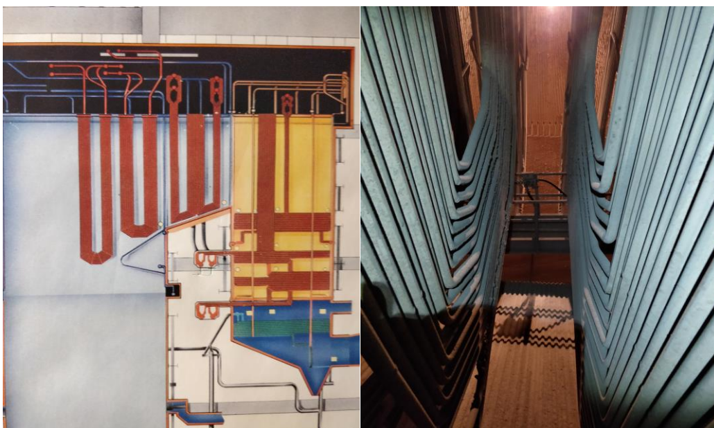
Kuva 6 ja 7. Kattilan nokan havaintokuva sekä ylhäältäpäin kuvattuna
