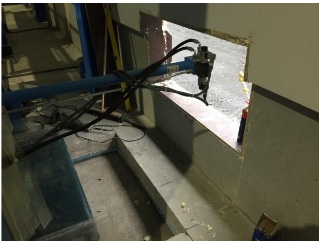
Kuva 17. Kuljettimen vaativat muutokset rakenteessa
