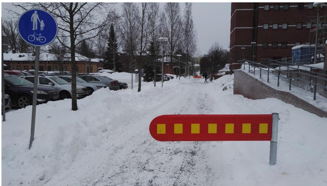
Kuva 4. BIR-jousipuomia Suokadun ja Tulliportinkadun välisellä puistoväylällä rajoittamassa ajoneuvoliikennettä (Lampio 2019-01-08)
