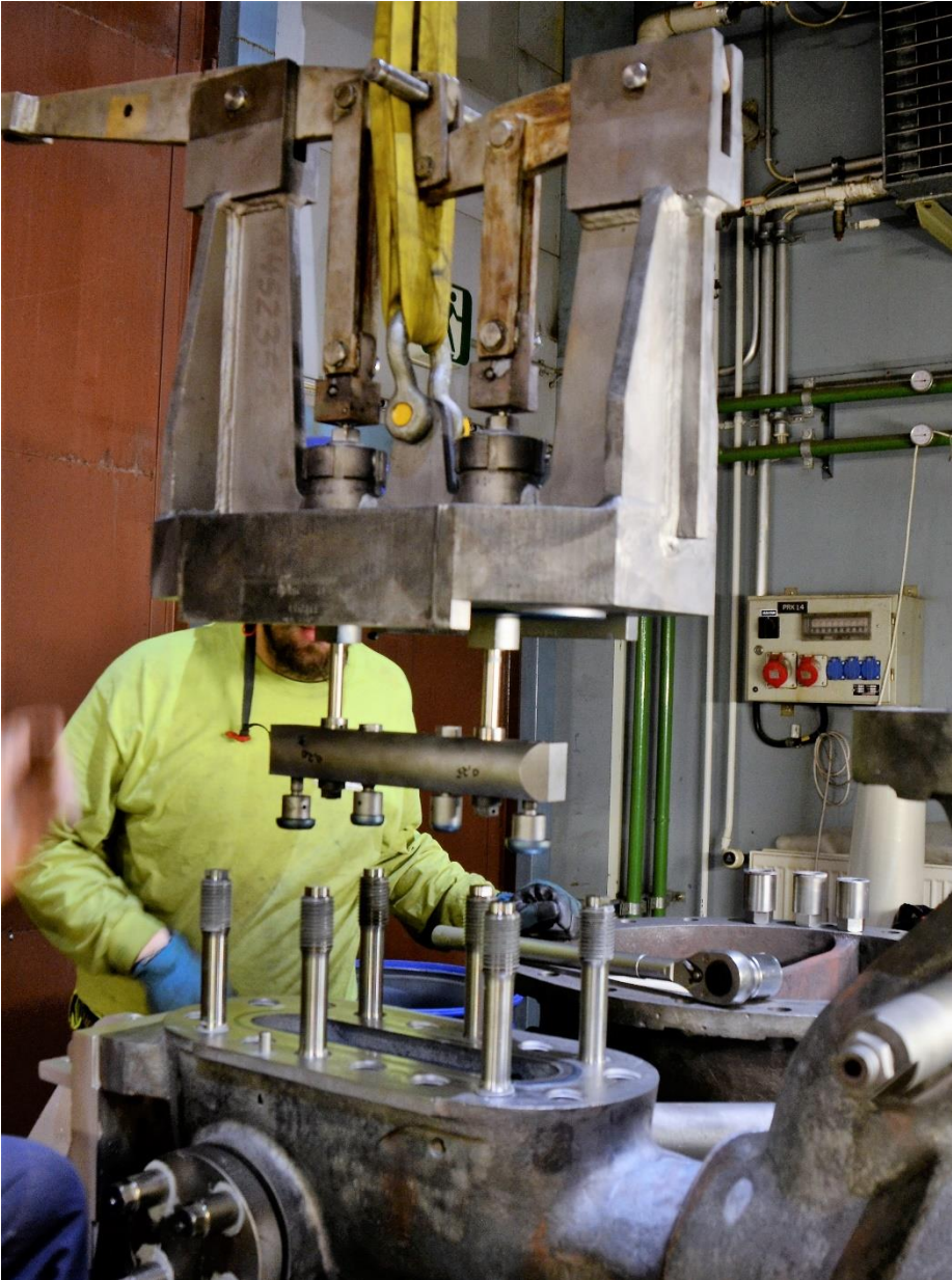
KUVA 60. Säätoventtiilin siniväritarkastus
