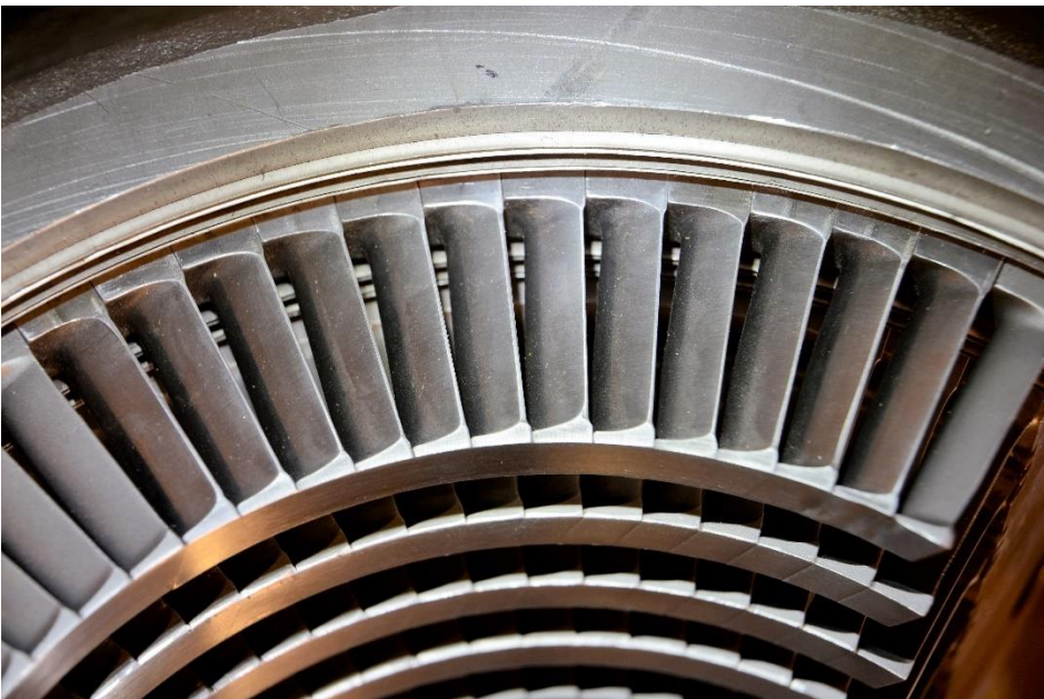
KUVA 55. Johtosiipikannattimeen vaihdettiin kaikkiaan 12 uutta siipeä
