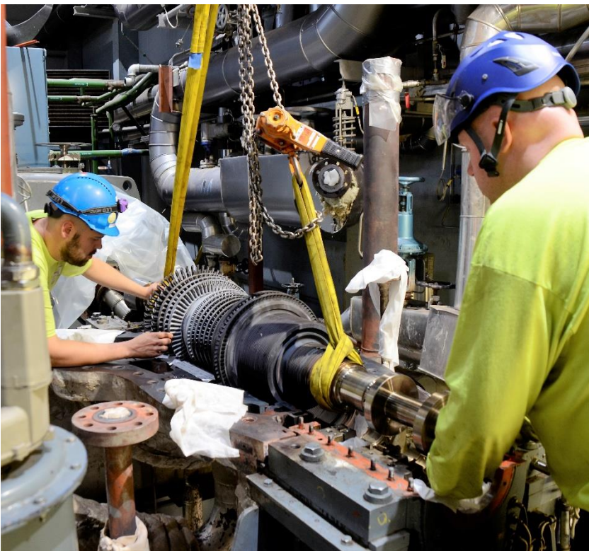
KUVA 39. Roottorin nosto
