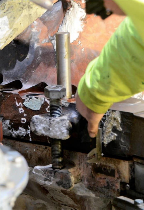
KUVA 33. Yläpesää kohotetaan aluksi nostopulteilla
