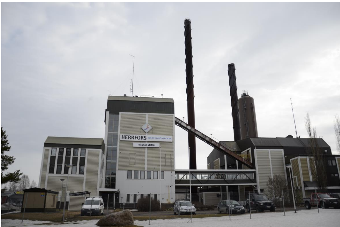
KUVA 1. Oy Perhonjoki Ab:n Vieskan Voiman voimalaitos Ylivieskassa
