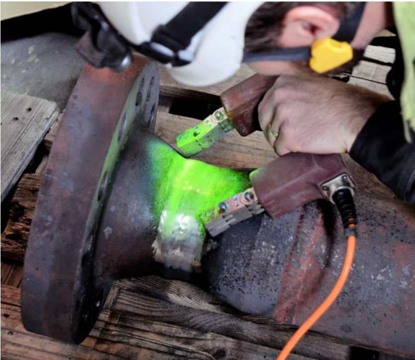
KUVA 72. Päähöryputken hitsisauman magneettijauh tarkastus
