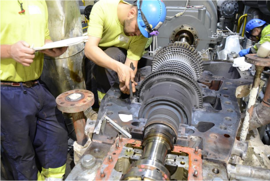
KUVA 7. Höryturbiini osittain purettuna
