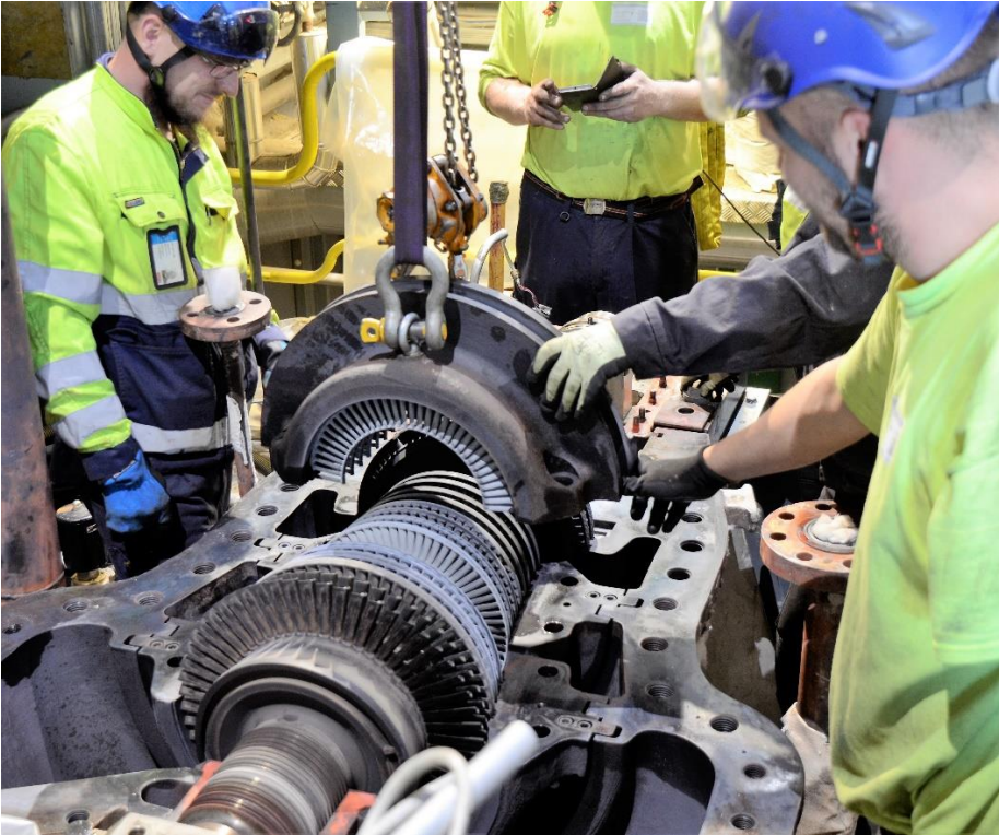
KUVA 36. Ylemmän johtosiipikannattimen nosto
