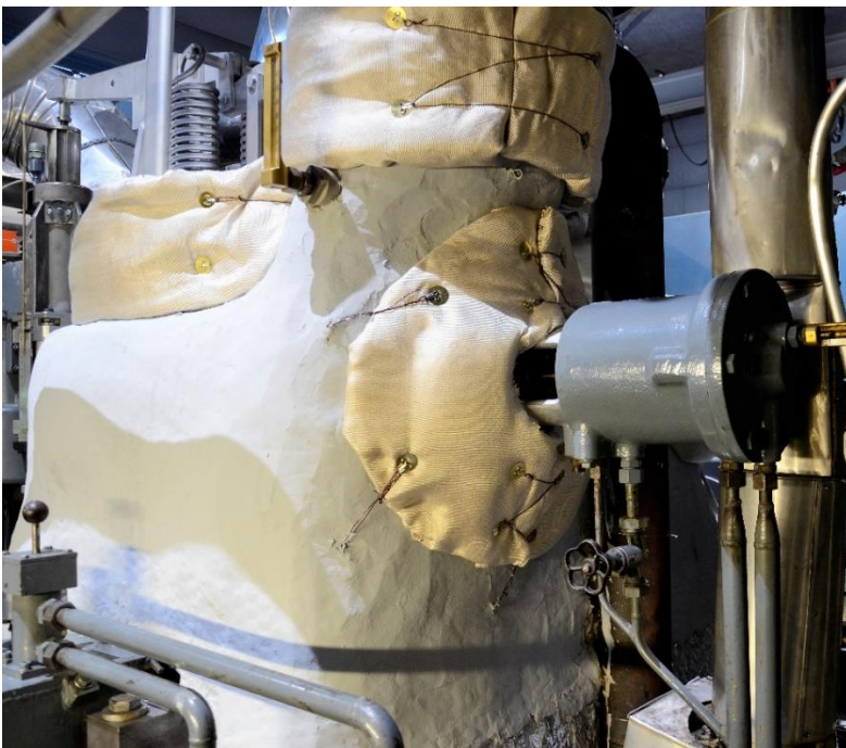
KUVA 71. Turbiini eristettynä
