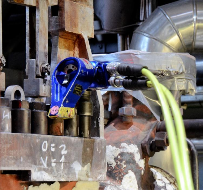
KUVA 31. Säästöventtiilin mutterit avattiin hydraulivääntimellä
