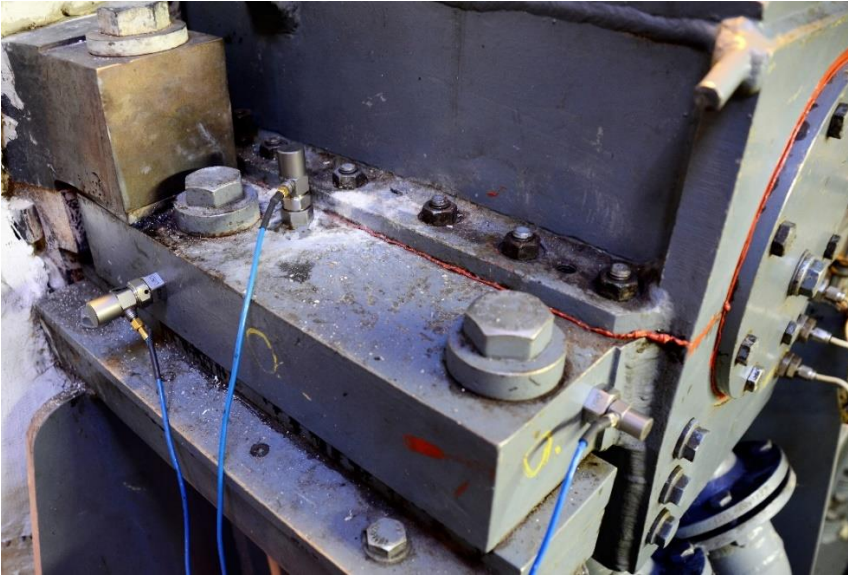
KUVA 20. Magneettikiinnitteiset kiihtyvyyssanturit asennettuna
