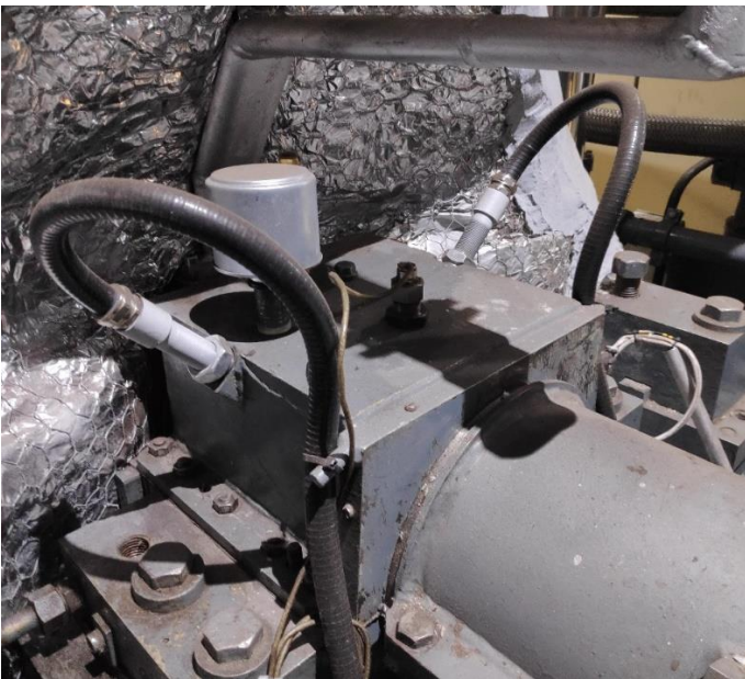
KUVA 85. Turbiiniakselin takapään värähtelymittaus
