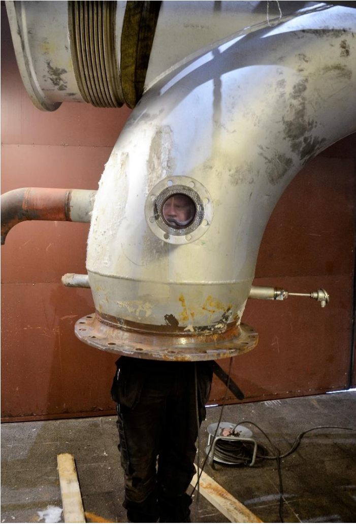
KUVA 77. Poistohöyryputken puhdistaminen hiomalla
