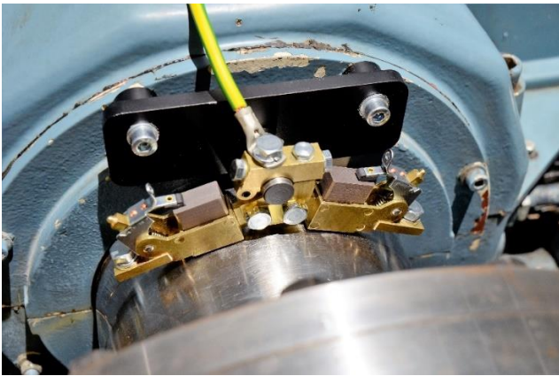
KUVA 82. Generaattoriakselin maadoitushiili
