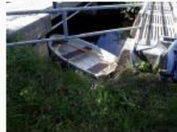
Kulkuväylä on sortunut.
