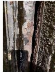
Rakenne on ruostunut puhki.
