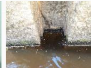
Rakenne on ruostunut puhki.
