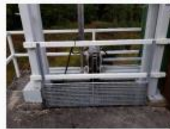
Likaisuutta havaittavissa, mutta metallirakenne on hyväkuntoinen. Lievä ruostuneisuus.
