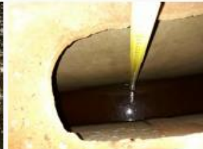
Rakenne on ruostunut puhki.
