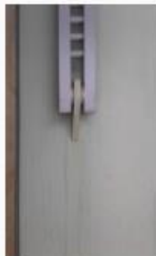
Likaisuutta havaittavissa, mutta metallirakenne on hyväkuntoinen. Lievä ruostuneisuus.
