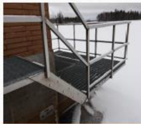
Väri värjänyt rakenteen. Lunkku on uuden veroinen.
