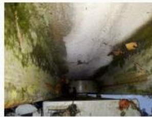
Likaisuutta havaittavissa, mutta metallirakenne on hyväkuntoinen. Lievä ruostuneisuus.
