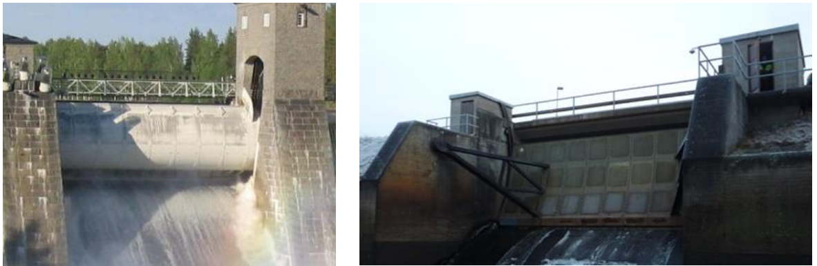
Kuva 4. Imatran kosken valssiluukku (vas.) Sääkskosken segmenttiluukku (oik.)
