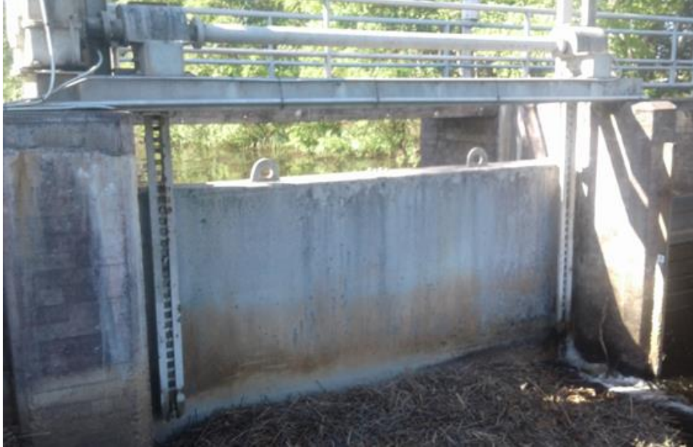
Kuva 11. Uretaanitäytteinen sulkuluukku
