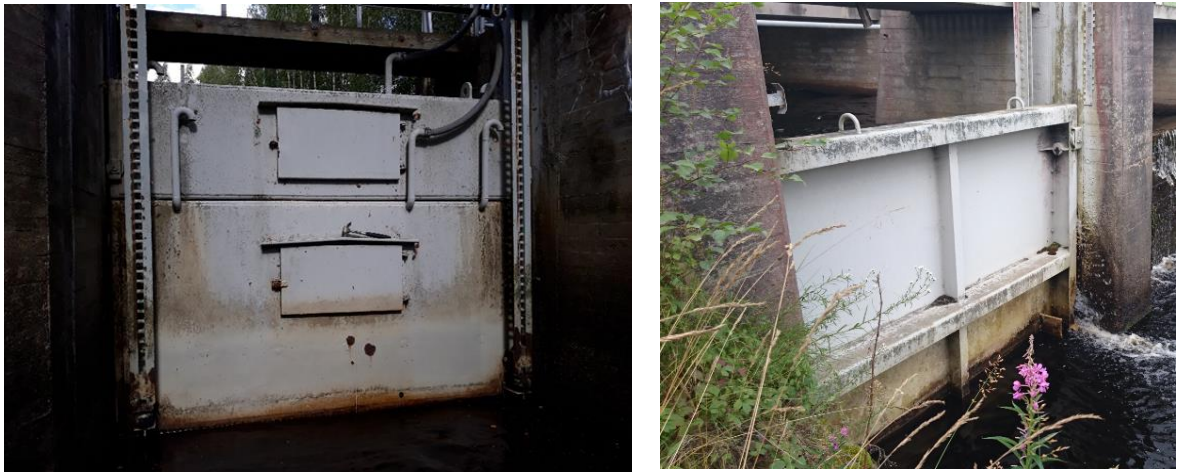
Kuva 10. Villalla eristetty luukku (vas.) Levymallinen teräspalkein vahvistettu luukku (oik.)
