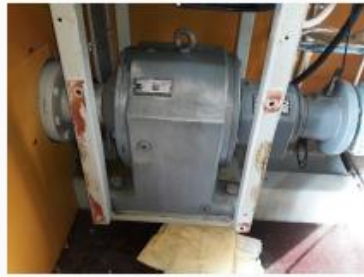
Vaihteisto hyväkuntoinen. (Tarkistetaan öljyt ja kuunnellaan ääntä sähkömoottorin käydessä)
