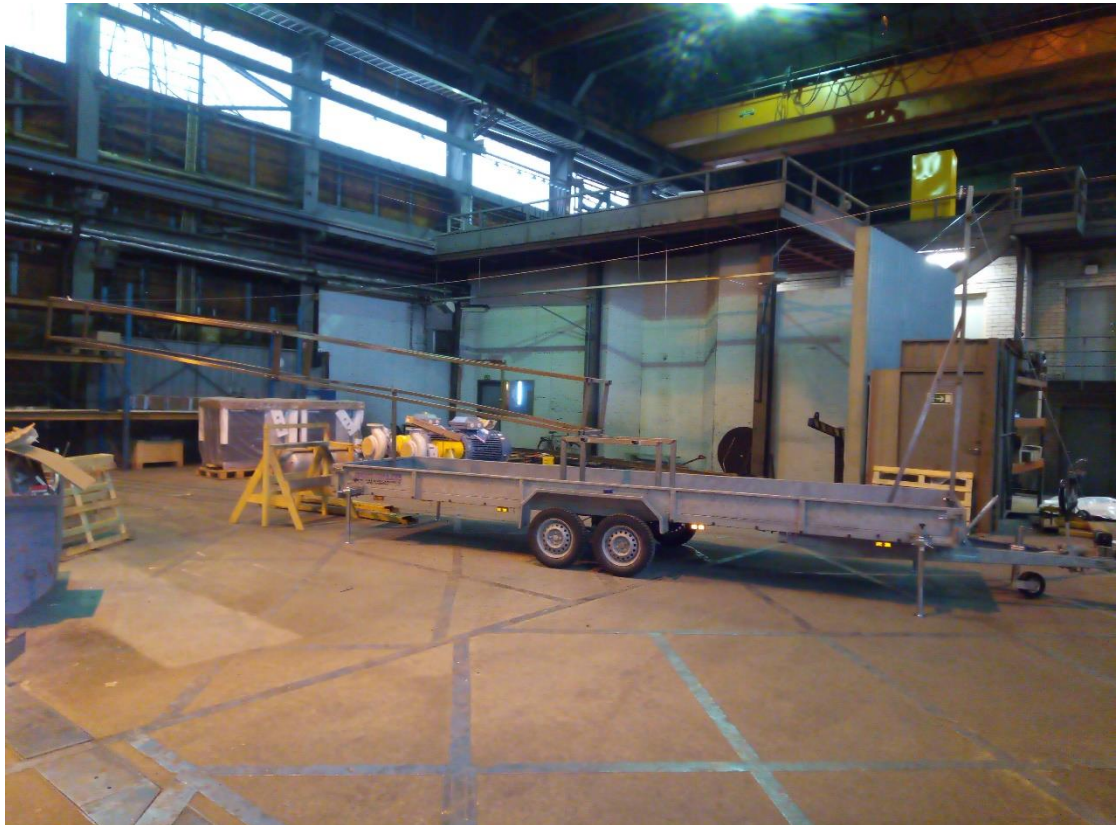
Kuva 9. Kehikko on kyljellään ja vinssin vaijeri on kiinnitetty kehikon yläosaan.
