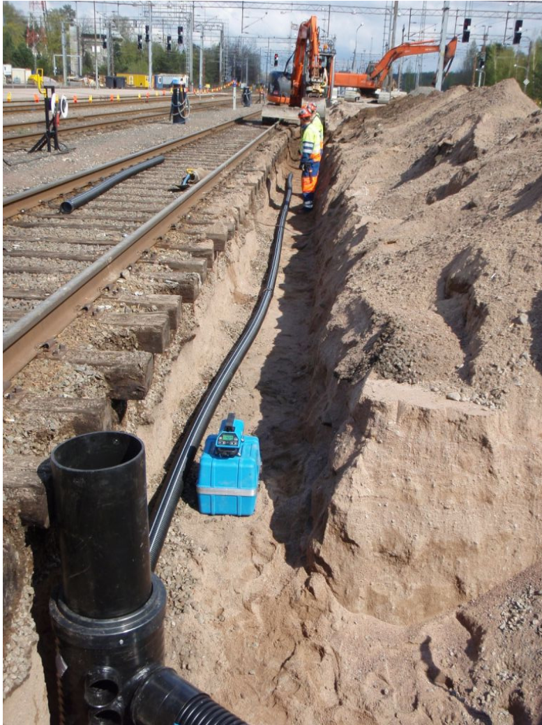
Kuva 6. Laiturin ja raiteen väliin rakennetut salaojalinjat
