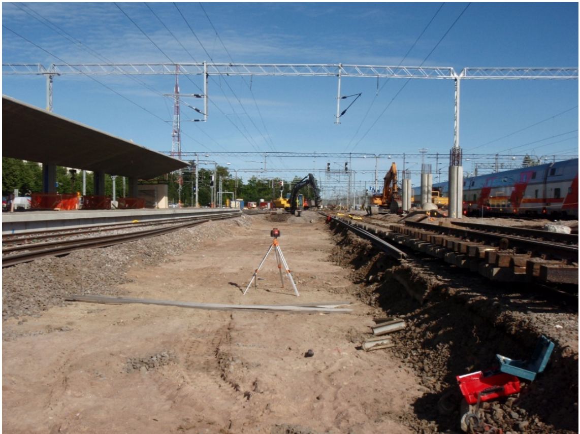
Kuva 7. Vanhat raiteet poistettuna sekä tukikerros kaivettuna
