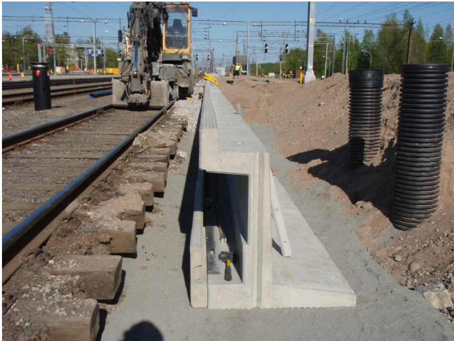
Kuva 4. Asennetut elementit odottamassa tarkemittausta
