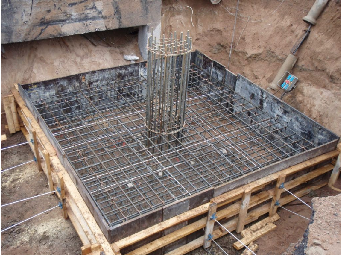
Kuva 5. Pilarinantura valmiiksi raudoitettuna ja odottamassa valua
