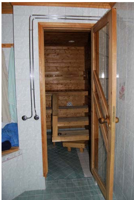
Kuva 12: Näkymä saunaan: tämänhetkinen ovilehti kaventaa entisestään oven vapaata aukkoa ja päästää alapuoleltaan liikaa viileää ilmaa kylpyhuoneesta löylyhuoneeseen.
