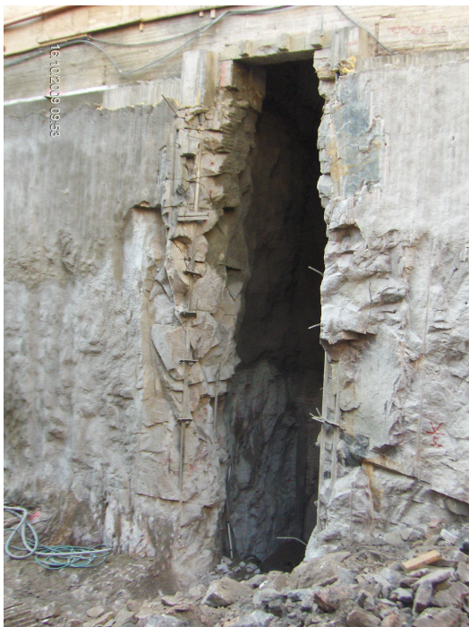
Kuva 7 Louhittu hissi-kuilu (Porapaalutuennat reunoilla)
