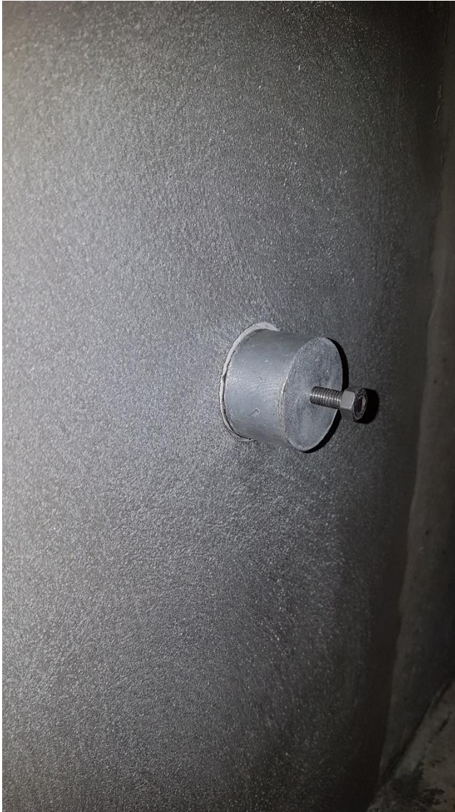
KUVA 6. Vedettävä kappale liimattuna tasoitteeseen
