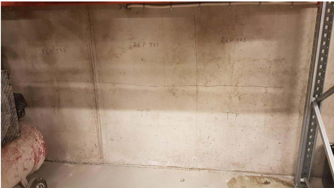
KUVA 1. Hallin betoniseinäelementti vetolujuuskokeiden alustana
