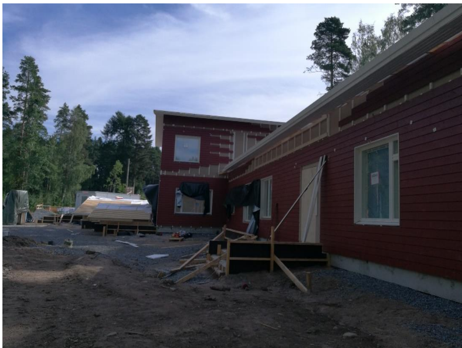
Kuva 17. Elementtiasennustyö käynnissä nuorten ryhmäkotityömaalla Nokialla.
