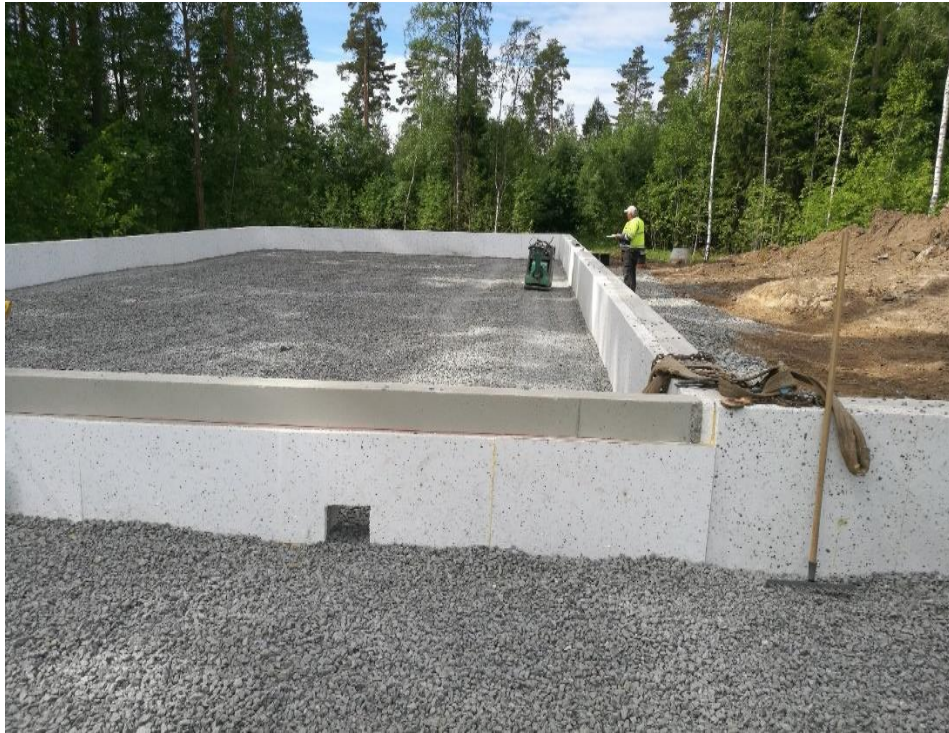
Kuva 15. Teräsbetonisokkeli valettu kapillaarikatkon päälle Nuorten ryhmäkodissa Nokiassa, ennen sisätäyttöä.
