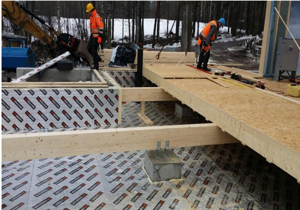
Kuva 19. Lattiana toimivan välipohjaelementin asennus lämpimään alapohjaan
