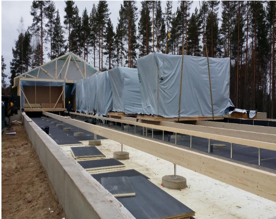
Kuva 14. Juuan vanhusten hoivakodin tehtaalla valmistettujen moduulien asennus käynnissä.
