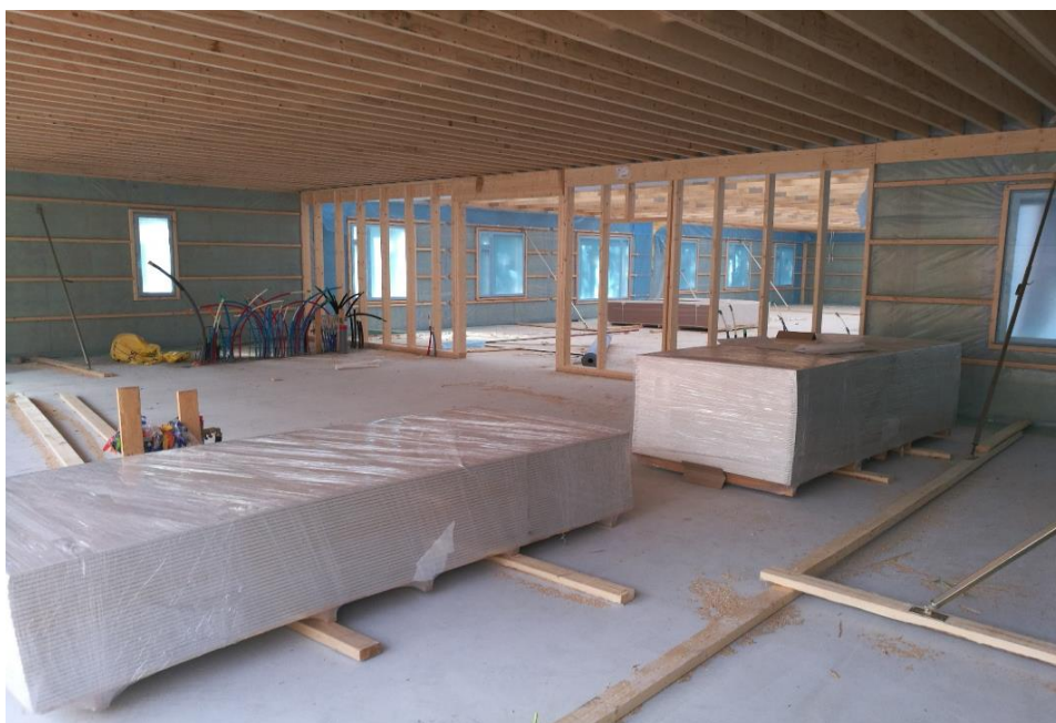
Kuva 18. Sisäpuolen kipsilevyniput nostettuna valetun lattian päälle.
