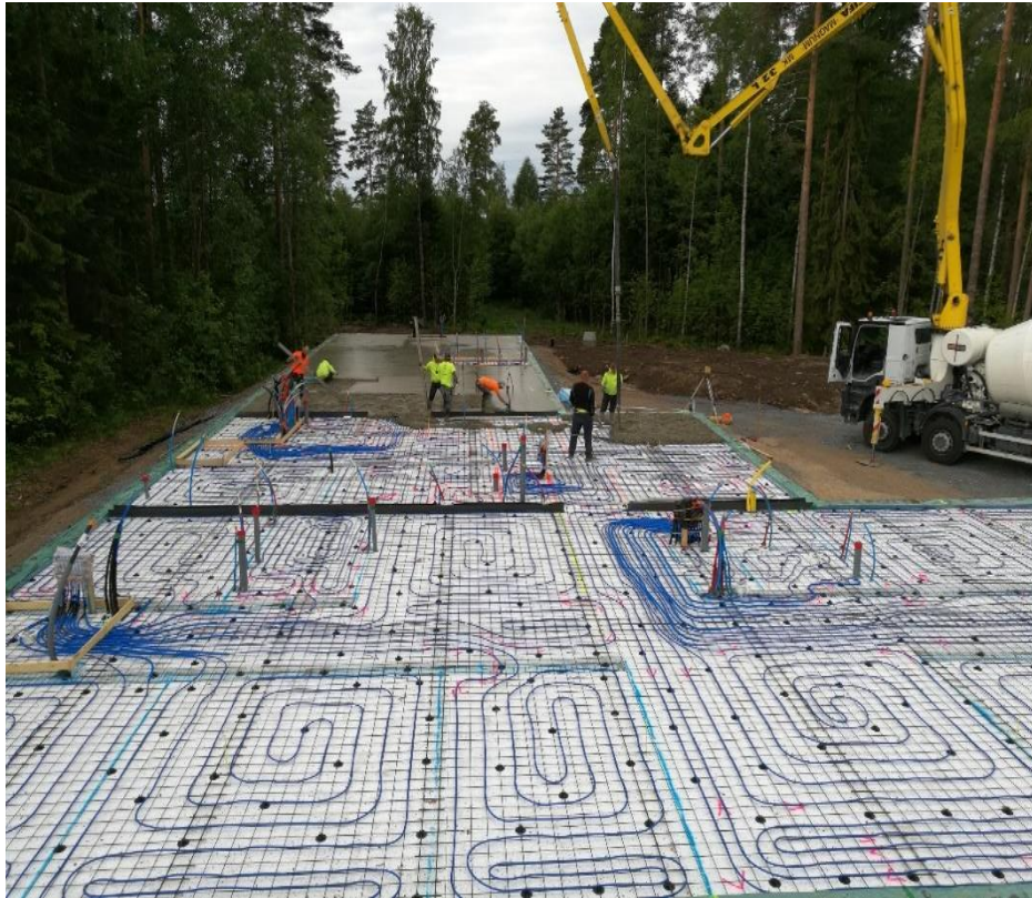
Kuva 16. Maanvaraisen lattian valutyö käynnissä nuorten ryhmäkodin työmaalla Nokiolla.
