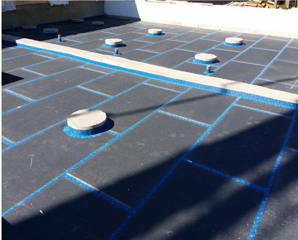
Kuva 5. Maanvaraisten eristeiden tiivistys (Hovako Oy, 2015)
