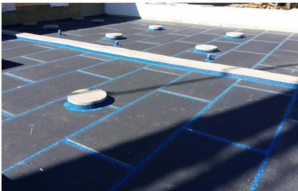
Kuva 20. Maanvaraisten eristeiden saumojen teippaus Juuan vanhusten hoivakotityömaalla Tescon teipillä.
