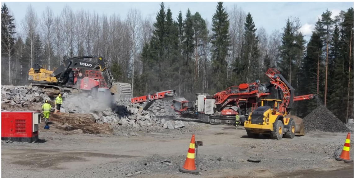
KUVA 11. Urakoitsijan 4 kaksivaiheinen murskauslaitos syöttö- ja altakantokoneineen (Kosonen 2018)
