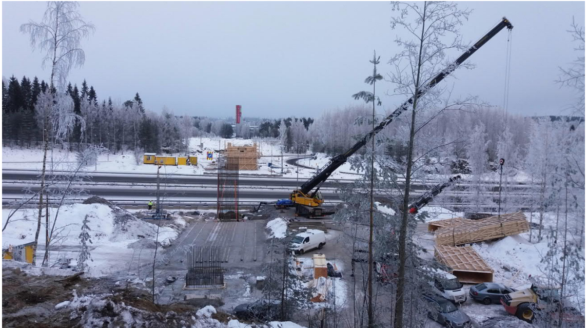
KUVA 3. Yleinen tie sekä siltatyömaa aiheuttaa merkittävän katkon maansiirron reitteihin. (Kosonen 2018)
