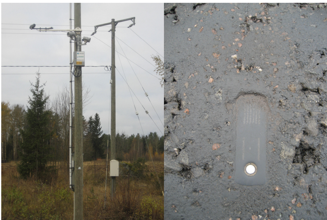
Kuva 9. Tiesääasema ja tien pinnassa oleva anturi antavat kelitietoa kelikeskuk-selle.
