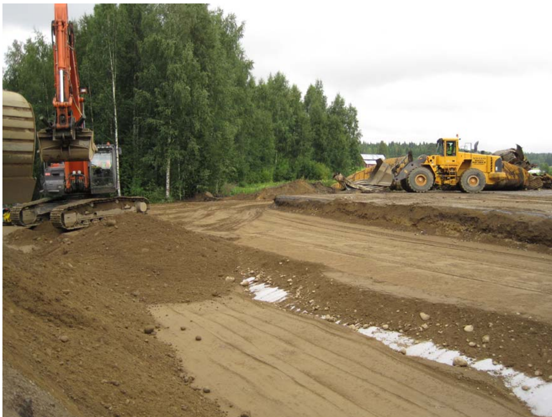
Kuvio 13: rakennekerrosten teko käynnissä
