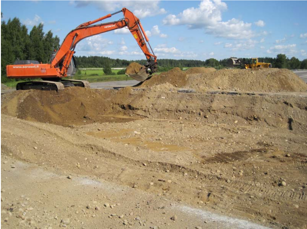
Kuvio 9: Rakennekerrosten kaivu ja läjitys
