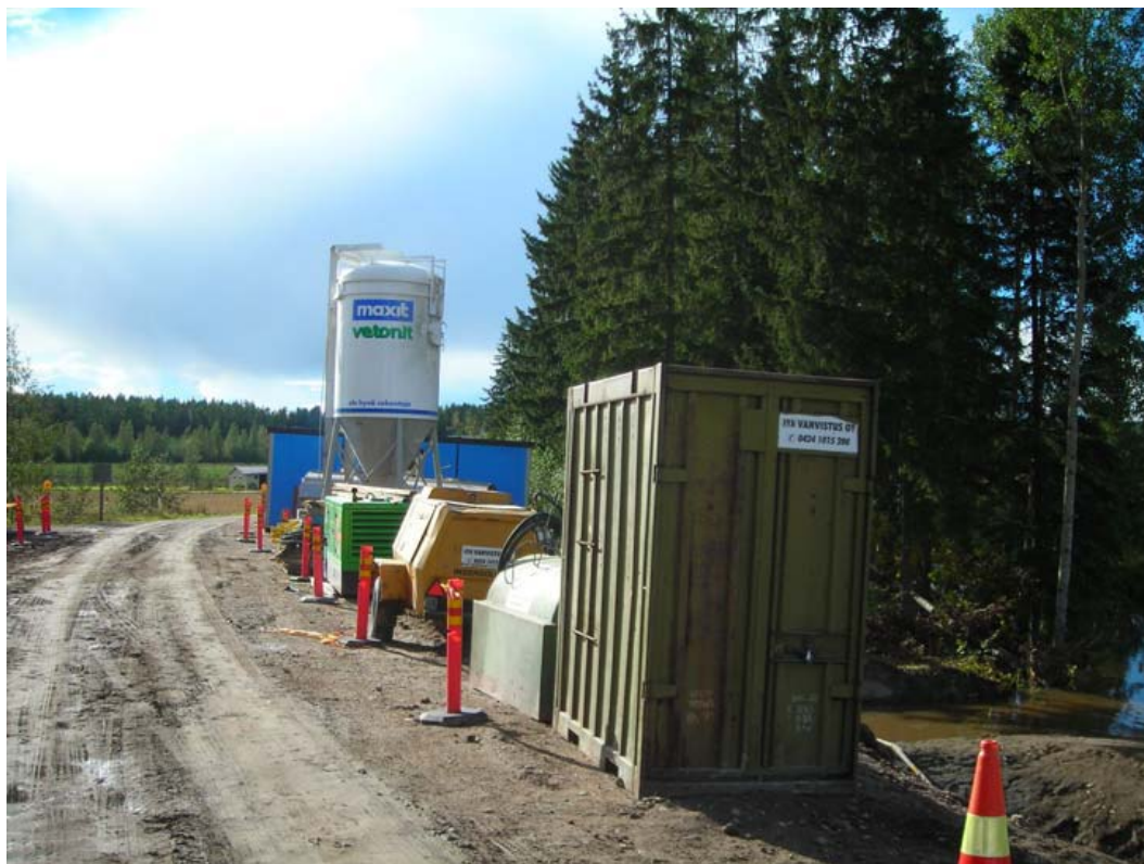
Kuvio 25: ruiskubetonointityömaan kalustoa (Kai Koho)
