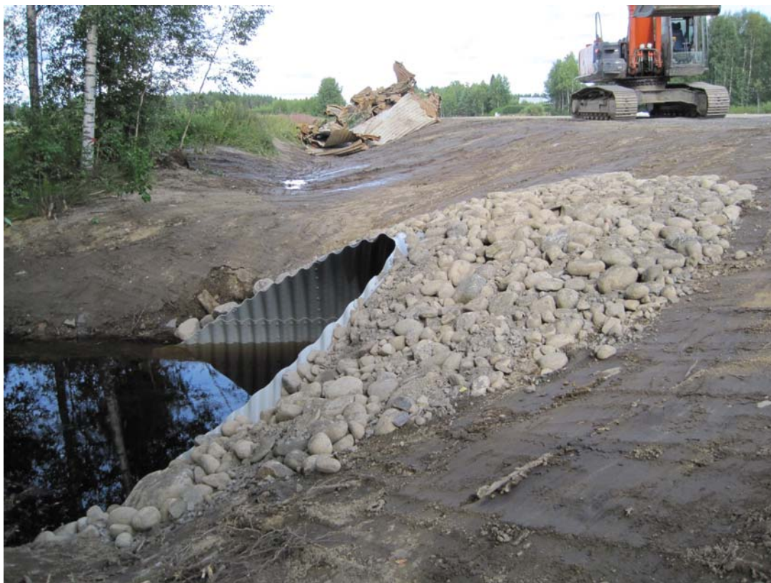
Kuvio 14: Kaiteita vaille valmis putkisiltatyömaa
