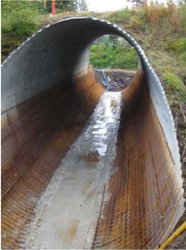
Kuvio 24: Putken seinämät verkotettuna ja tasausvalu tehtynä (Kai Koho)
