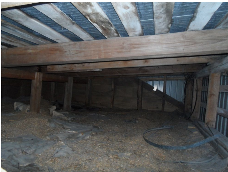
Kuva 3. Ullakolta kuvattu päätyseinä (Matilainen 2019)
