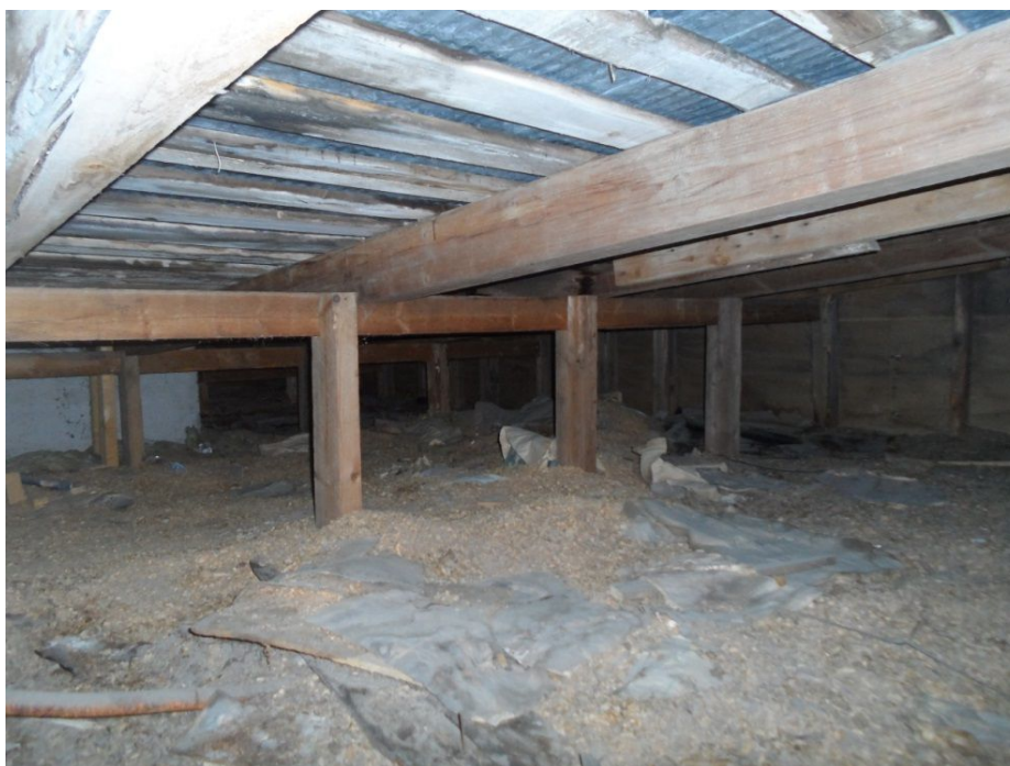
Kuva 14. Yläpohjan yleiskuva (Matilainen 2019)
