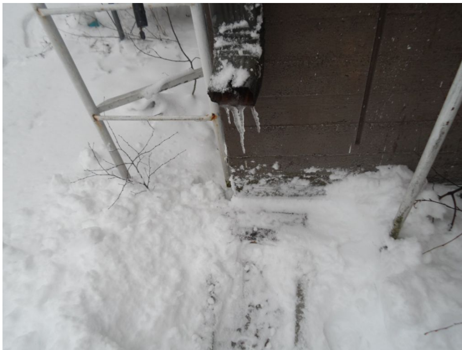
Kuva 20. Syöksytorni ja betonikouru (Matilainen 2019)
