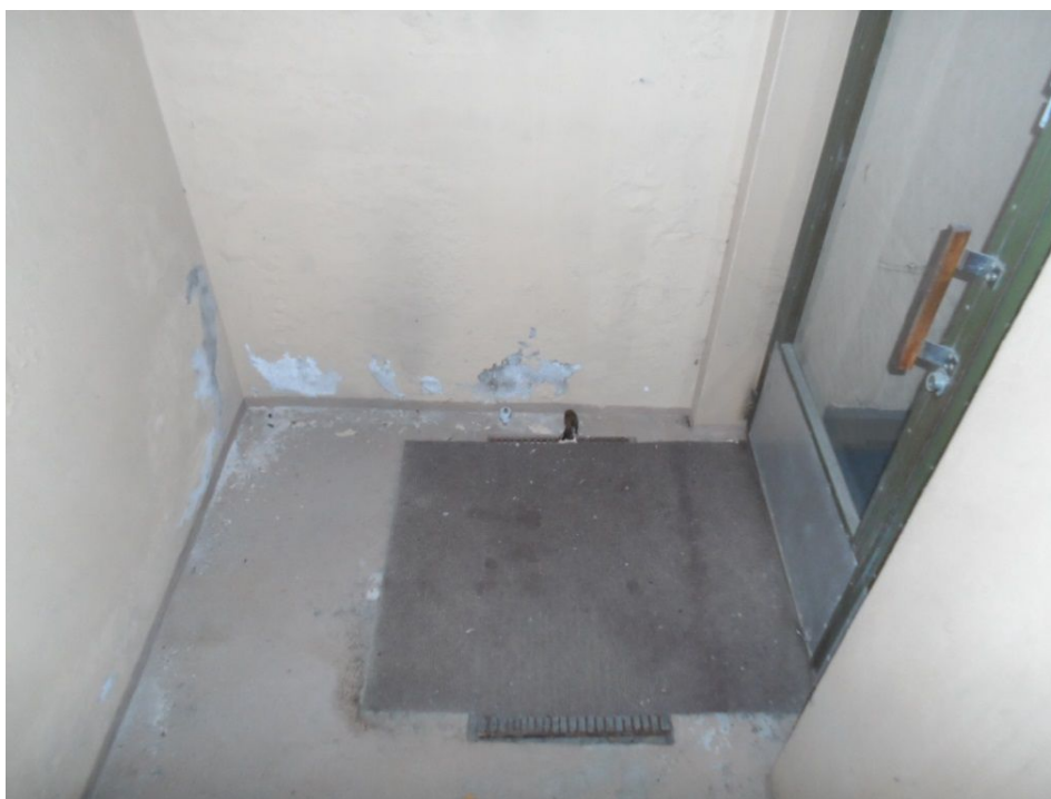
Kuva 10. Kellarin sisäänkäynnin seinämät laajennusosassa (Matilainen 2019)
