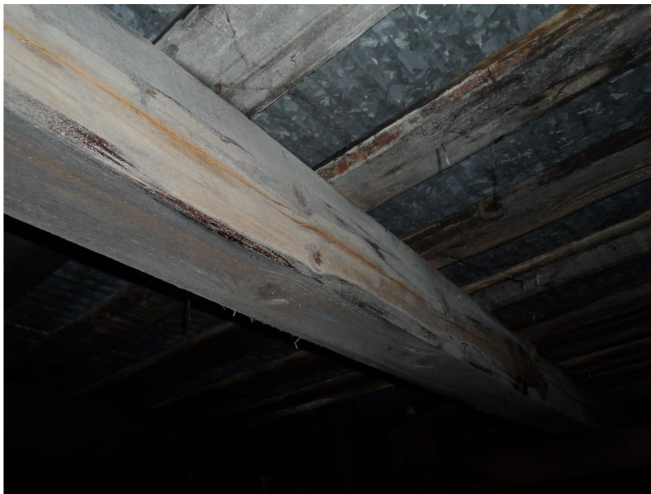
Kuva 13. Yläpohjan yläpuolisia kattorakenteita (Matilainen 2019)
