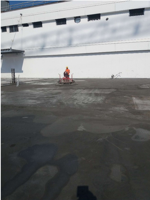
KUVA 13. Pinnan hierto käynnissä
