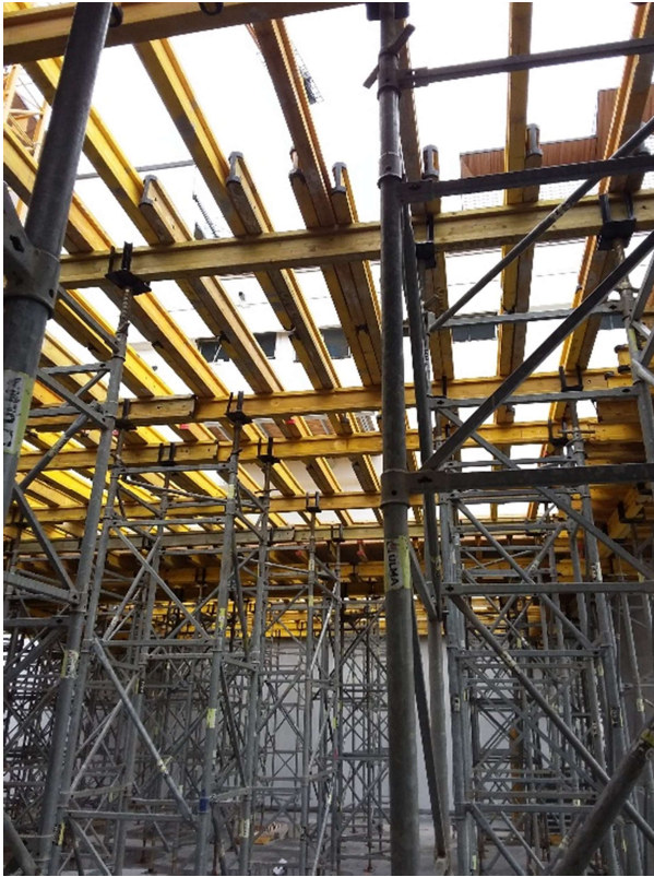
KUVA 6. Laatan muottipalkit asennettuna
