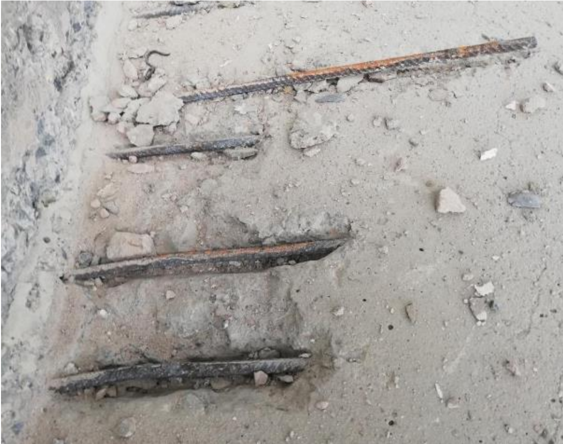
KUVA 2. Esiinpiikattuja raudoitusteräksiä. Teräkset, joiden toinen pää on irti, yleensä katkaistaan.
