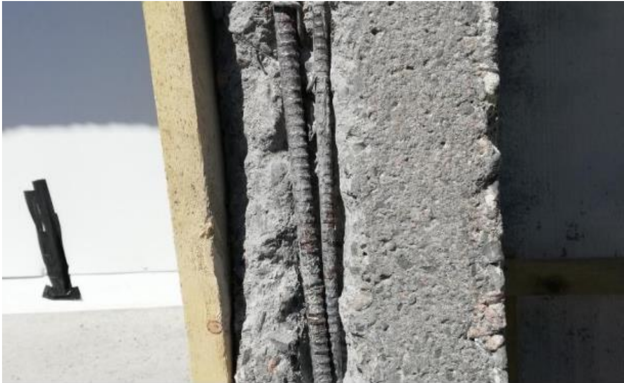
KUVA 3. Ruosteesta puhdistettu ja upotettu teräs ja muotitettu kuoppa.
