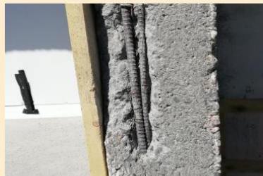
KUVA 2. Ruosteesta puhdistettu ja upotettu teräs ja muotitettu kuoppa.
