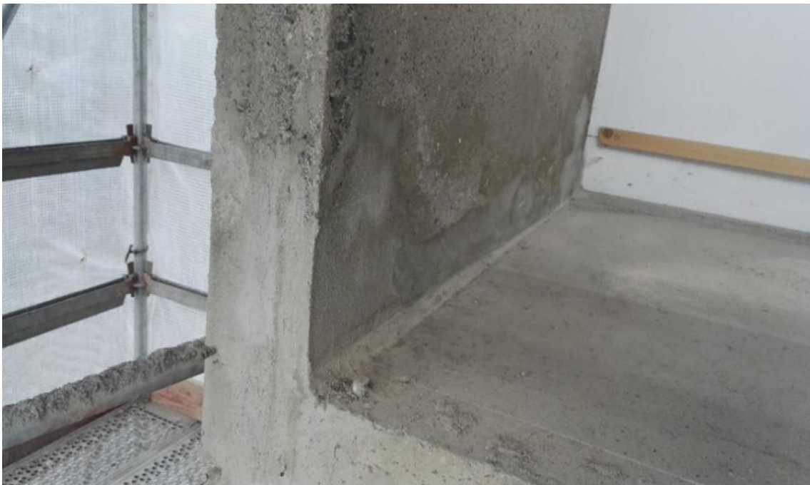
KUVA 6. Valmis ja kuivunut laastipaikkakorjaus.
