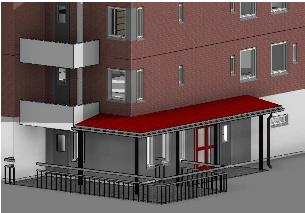
Kuva 17. Kellarikerroksen sisäänkäyntikatot (Kosonen 2019)
