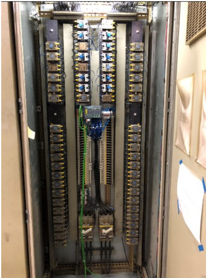
Kuva 37. Sähkökaappi CP9 työn lopussa.
