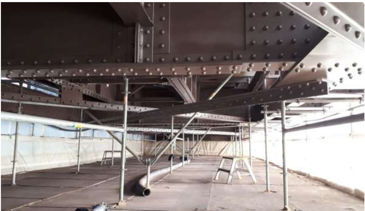
KUVA 9. Telineiden pohjalta hiekkapuhallusjäte imuroidaan talteen
