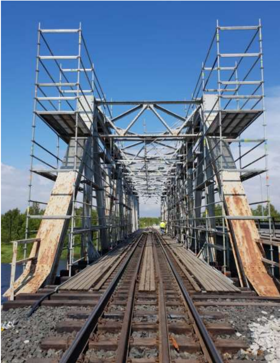
KUVA 7. Kraaselinsalmen ratasillan telineiden rakentaminen käynnissä
