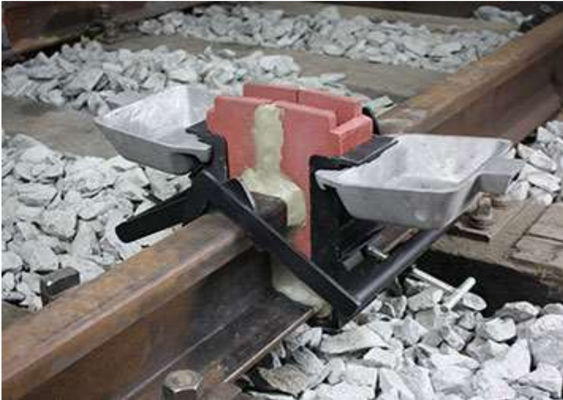
KUVA 19. Termiittihitsauksen muotit valmiina esilämmitystä varten. (22)
