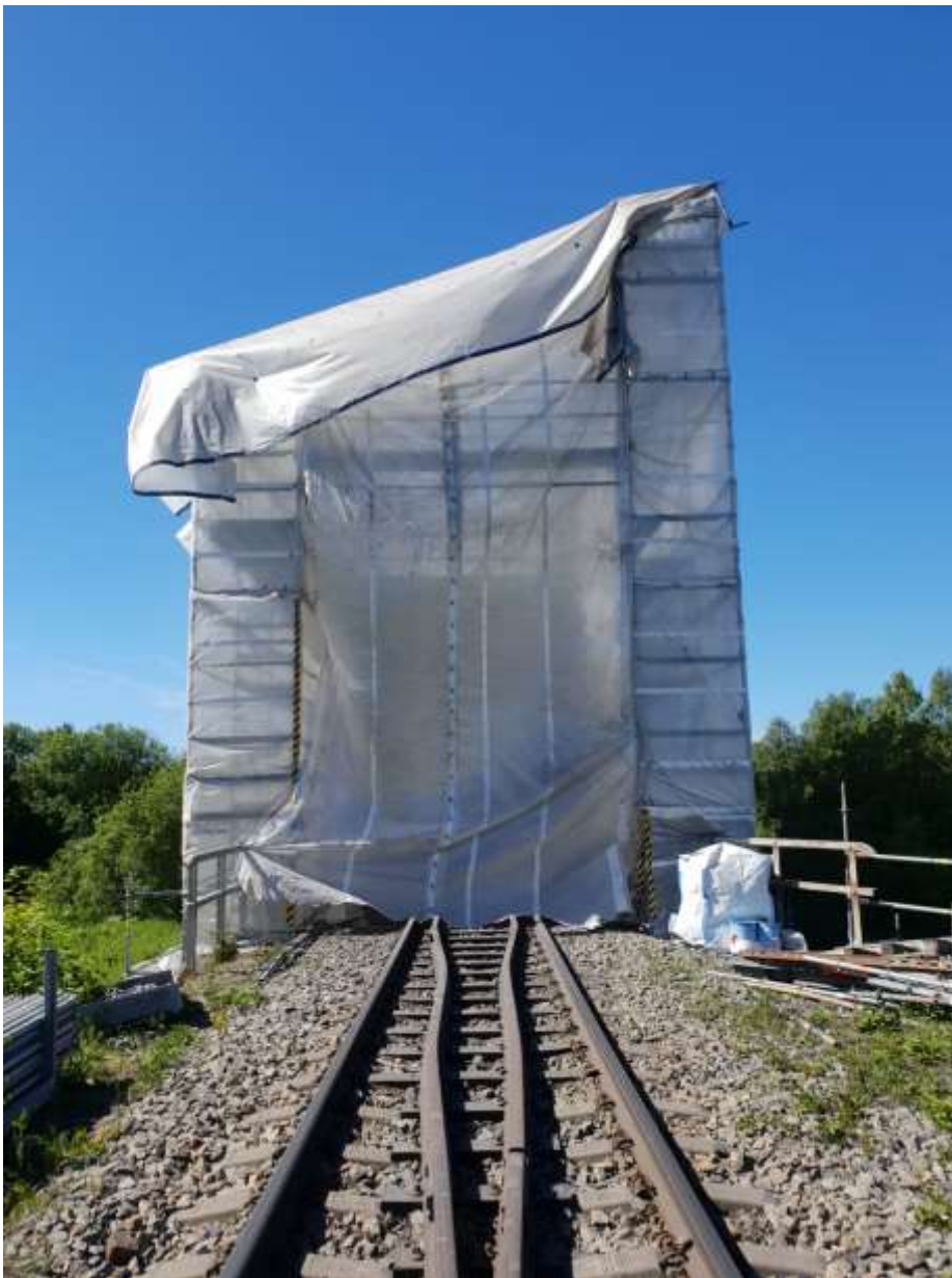
KUVA 8. Kaakamojoen ratasillalla hiekkapuhallus käynnissä sääsuojien sisällä
