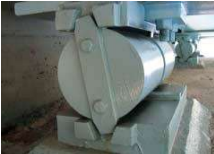
KUVA 10. Sillan teräslaakeri (17, s. 3)
