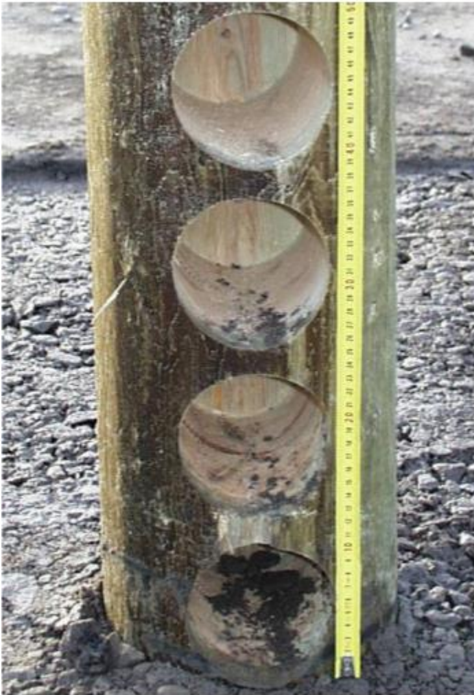
KUVA 4. JRK tekniikan menetelmällä heikennetty pylväs. Kuvasta puuttuu reikien päälle tuleva peitepelti (6, s. 5).
