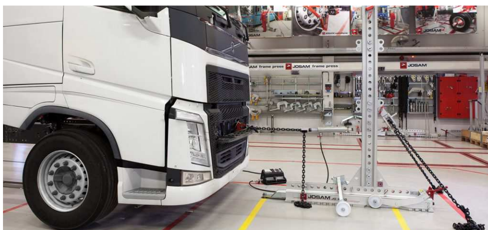
Figur 2. Riktning av lastbilshytt med Josams hytt-torn. (Car-O-Liner Group AB/Josam – Cab Tower, 2017)
