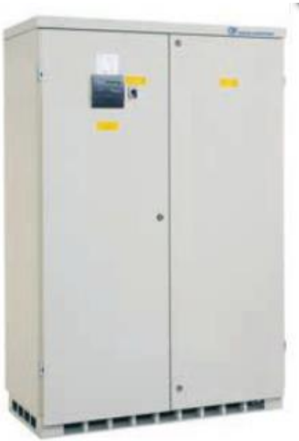
Figur 18. Det statiska batteriet som installerades. (Nokian Capacitors)
