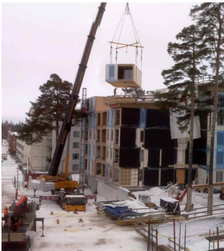
KUVA 5. Pihapetäjän tilaelementin asennus (Joensuunpihapetaja.fi)
