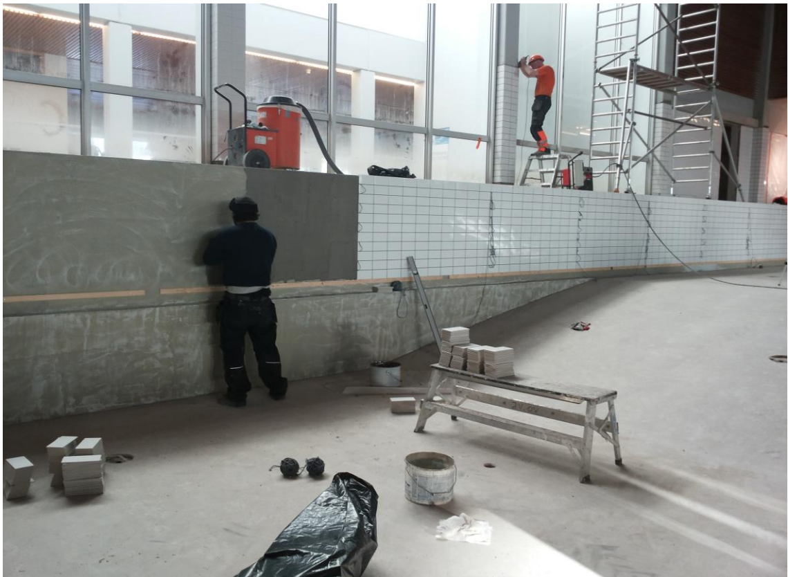
Kuva 4, Irat Samaletdin, seinälaatoitus käynnissä
