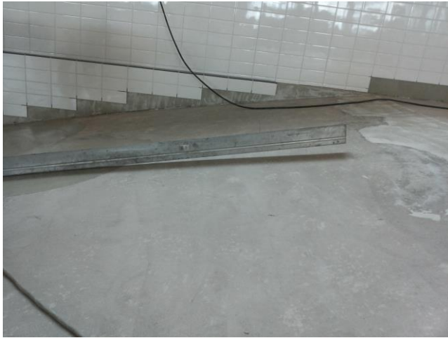
Kuva 9, Irat Samaletdin, Lattian suoruuden tarkistus
