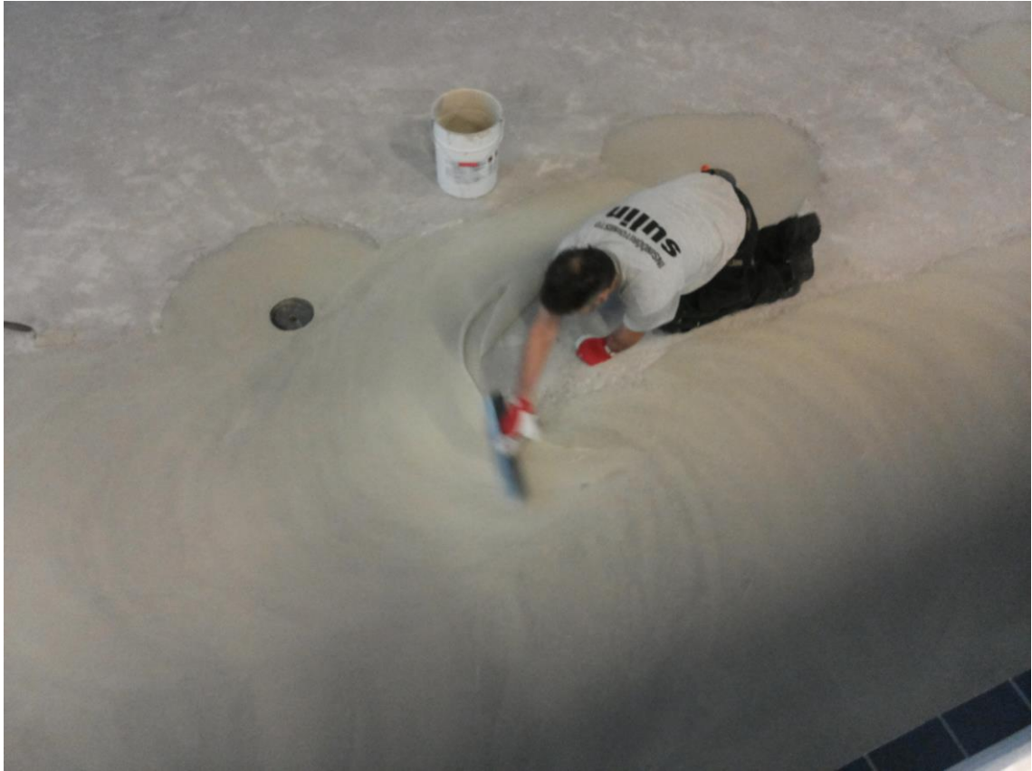
Kuva 3, Irat Samaletdin, epoksihartsin levitystä
