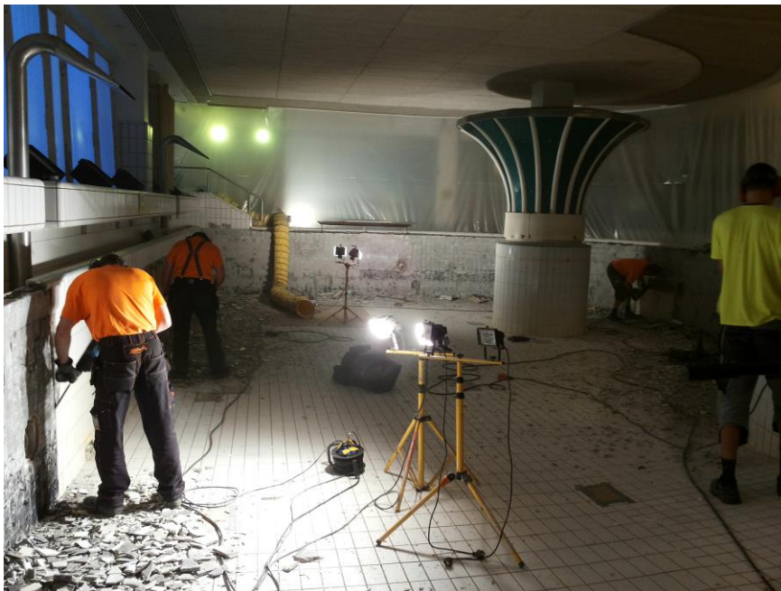
Kuva 1, Irat Samaletdin, purkutyöt käynnissä
