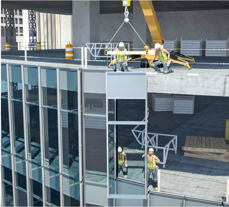
KUVA 13. Laselementtien asennusta kerroksessa olevaa nosturia apuna käyttäen (Schüco Suomi. 2019)
