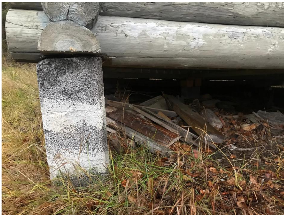
KUVA 6. Peruspilarin painauma. (Pokkinen 2018)
