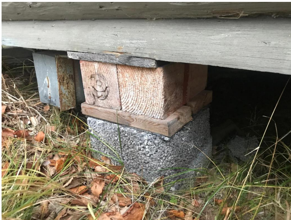
KUVA 2. 6*6 parrun kiinnitys (Pokkinen 2018)
