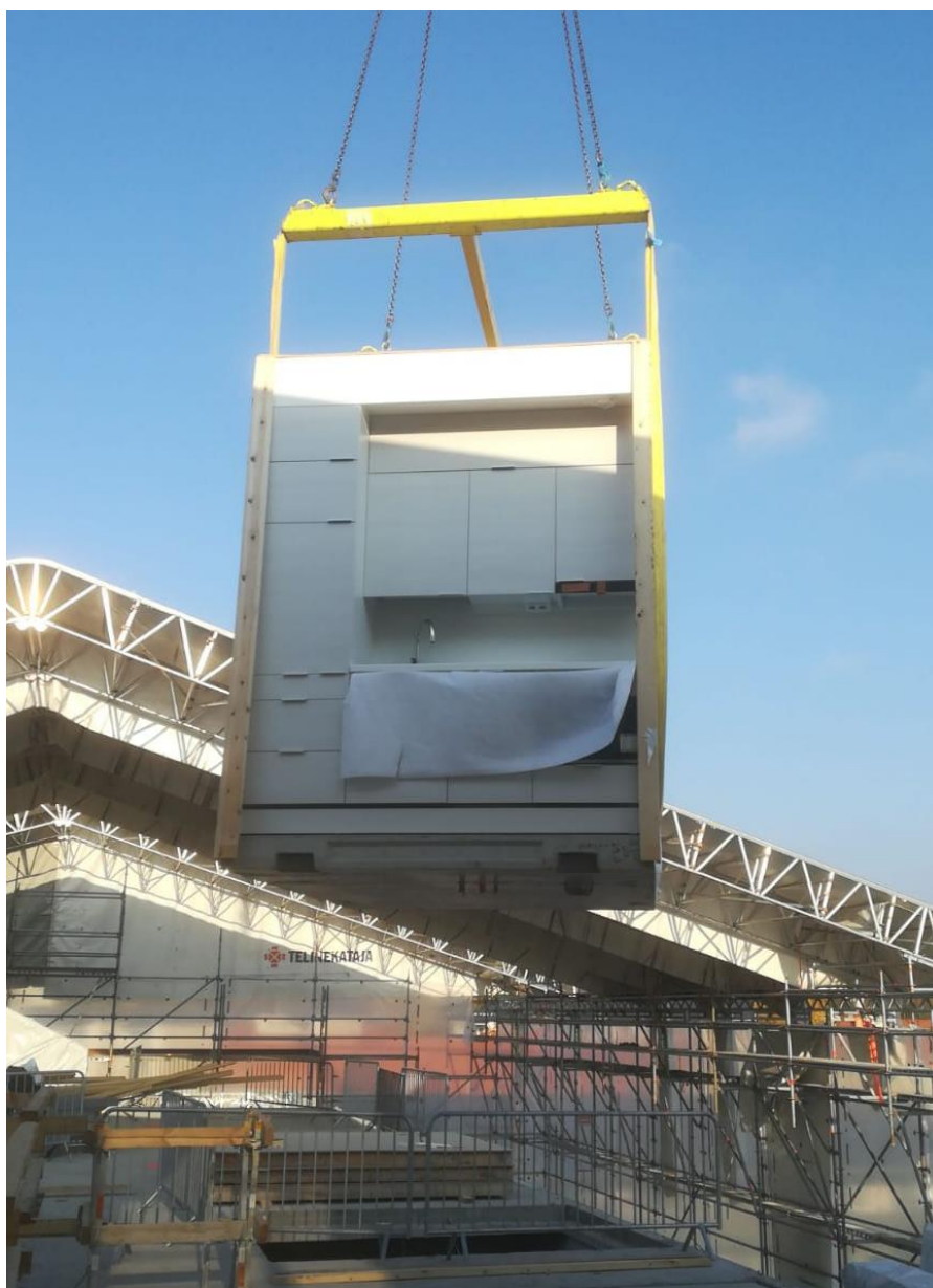
Kuva 13. Tekniikkastudion asennus meneillään. Taustalla näkyy sääsuoja, josta avattu lohko studion asennusta varten.
