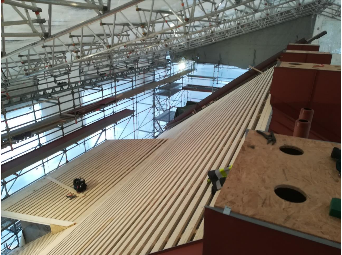
Kuva 10. Valaistuissa ja kuivissa olosuhteissa asennustyö tapahtuu nopeasti ja tehokkaasti.
