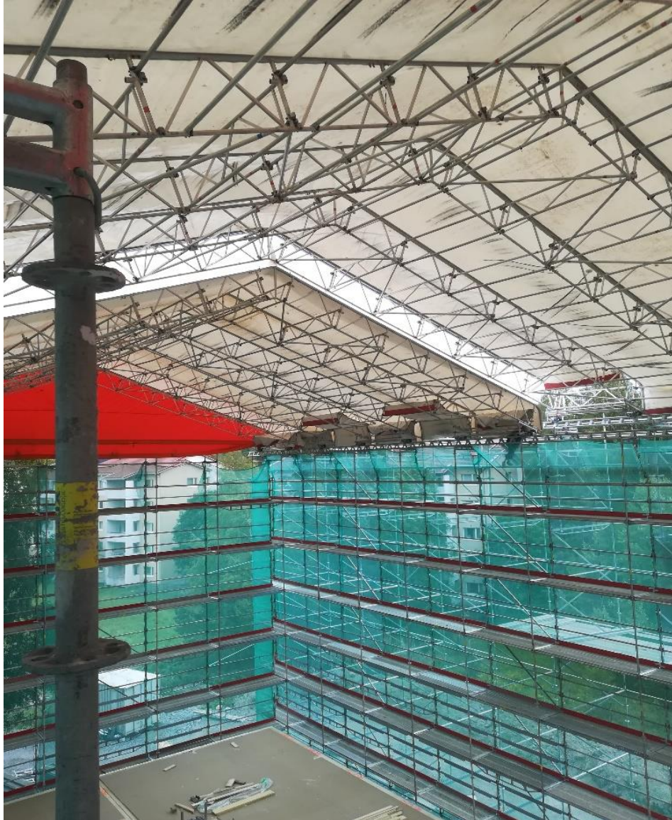
Kuva 9. Kohteeseen on asennettu sääsuoja ennen rakentamisen aloitusta.
