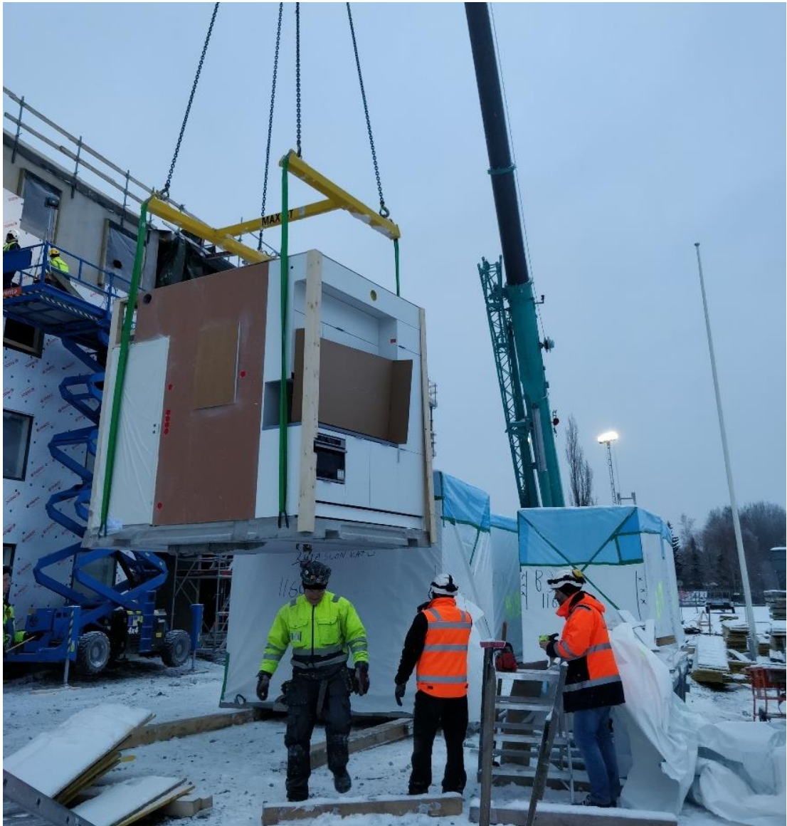
Kuva 6. Tekniikkastudion nosto alkamassa.
