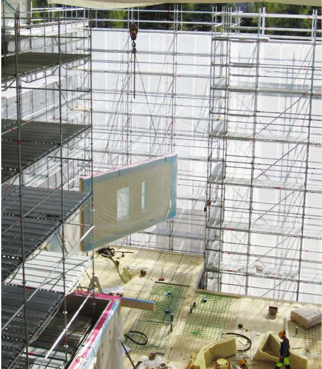
Kuva 4. Säätuojan sisällä tapahtuvaa elementtiasennusta. (Ratu S-1232, 2013).
