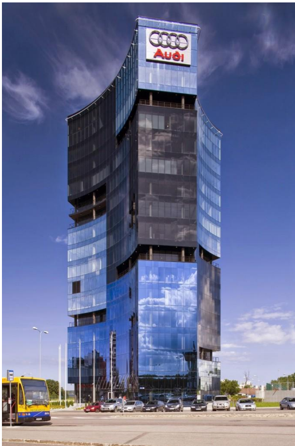
Kuva 3. Tallinnassa sijaitseva toimistorakennus, jonka välipohjat ovat kuitubetonia. (Rammehitus.ee)
