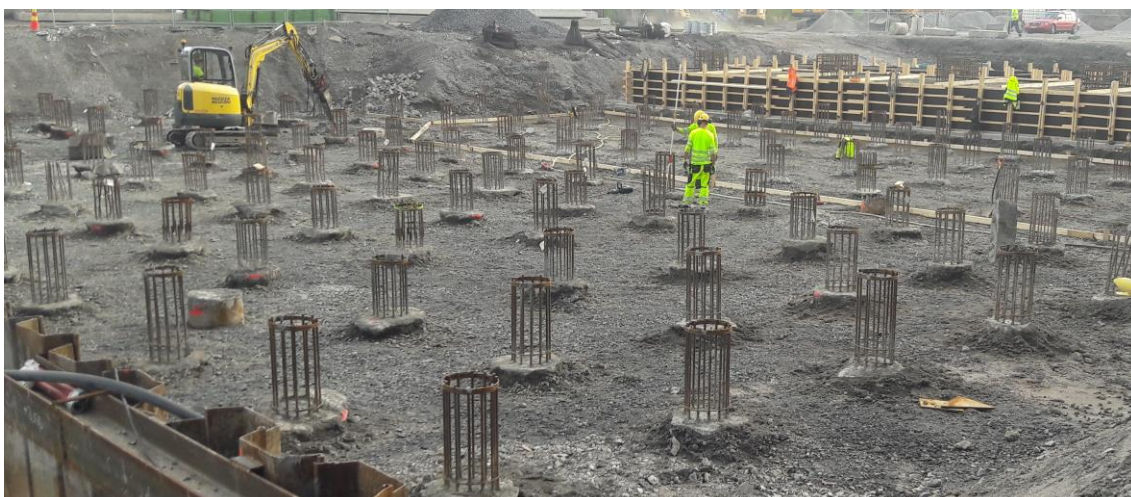
Kuva 19. Ylimääräinen maa-aines poistettu ja yläpäiden siistiminen käynnissä [Santeri Mustonen 2018.]
