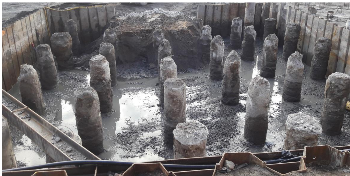
Kuva 17. Esiin kaivetut paalut. [Santeri Mustonen 2018.]
