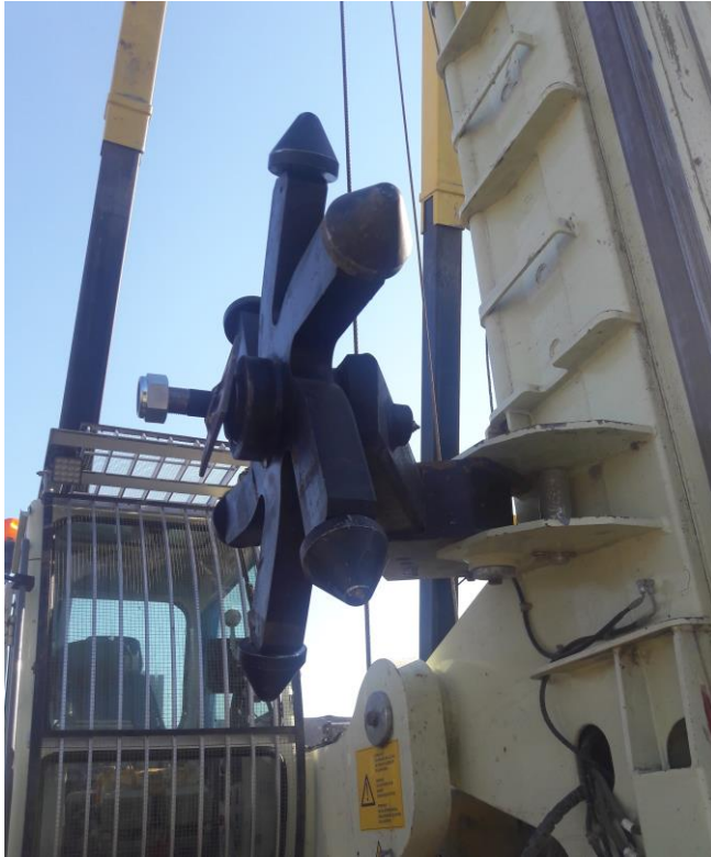
Kuva 11. Esimerkki kairan puhdistimesta. Kuvassa on käynnissä puhdistimen asennus. [Santeri Mustonen 2018.]
