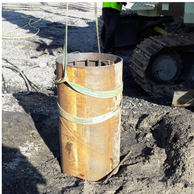
Kuva 14. Koepaalun jatkosputken asettelua [Santeri Mustonen 2018.]
