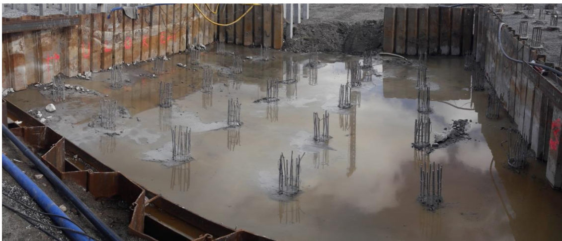
Kuva 18. Paalut katkaistuna oikeasta korosta sekä raudoitteet piikattu esiin [Santeri Mustonen, 2018.]
