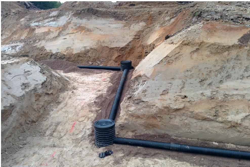
Kuva 8. Salaojien asennus seinälinja merkittynä. Huomaa turvalliset viisteet.
