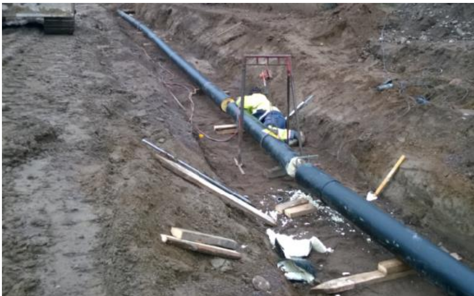
Kuva 9. Lämpökanaalin hitsaus.
