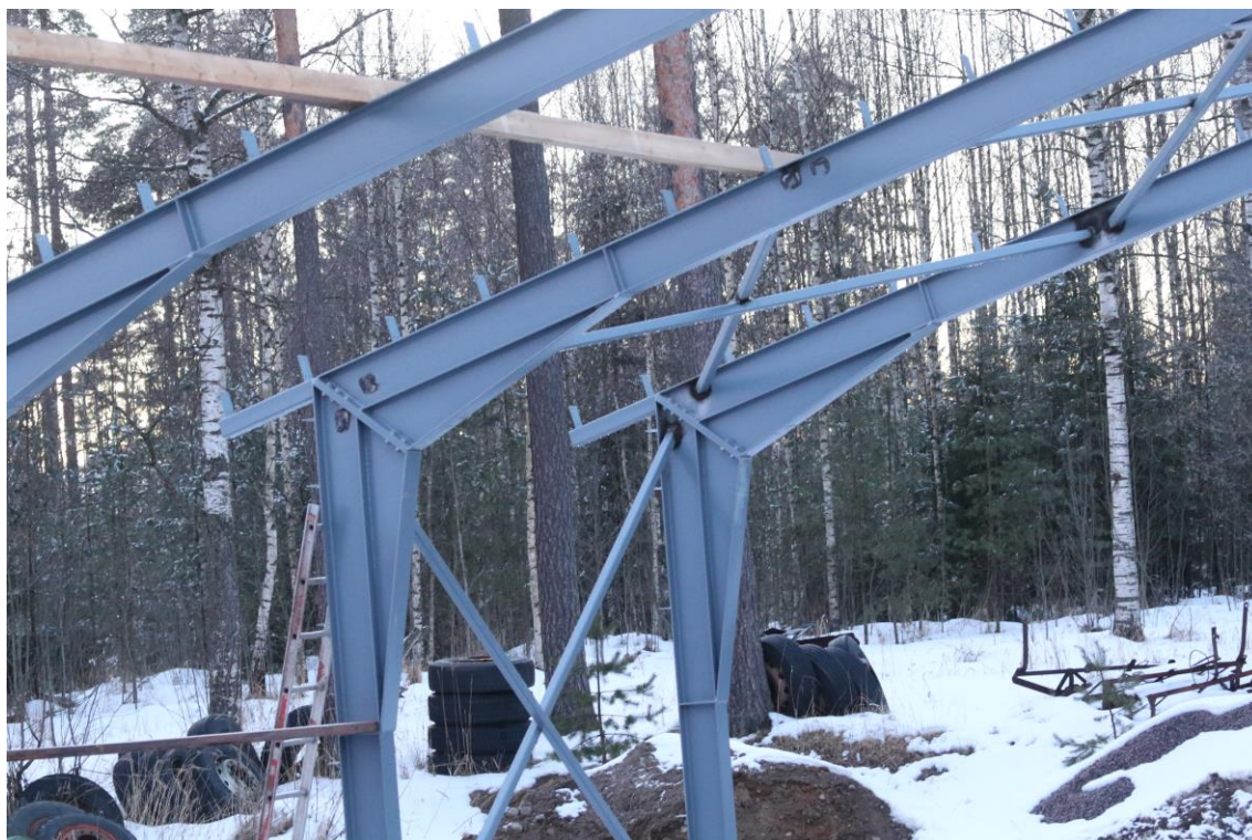
Kuva 12. Teräskehät asennettuna ja tuulisiteet hitsattuna.
