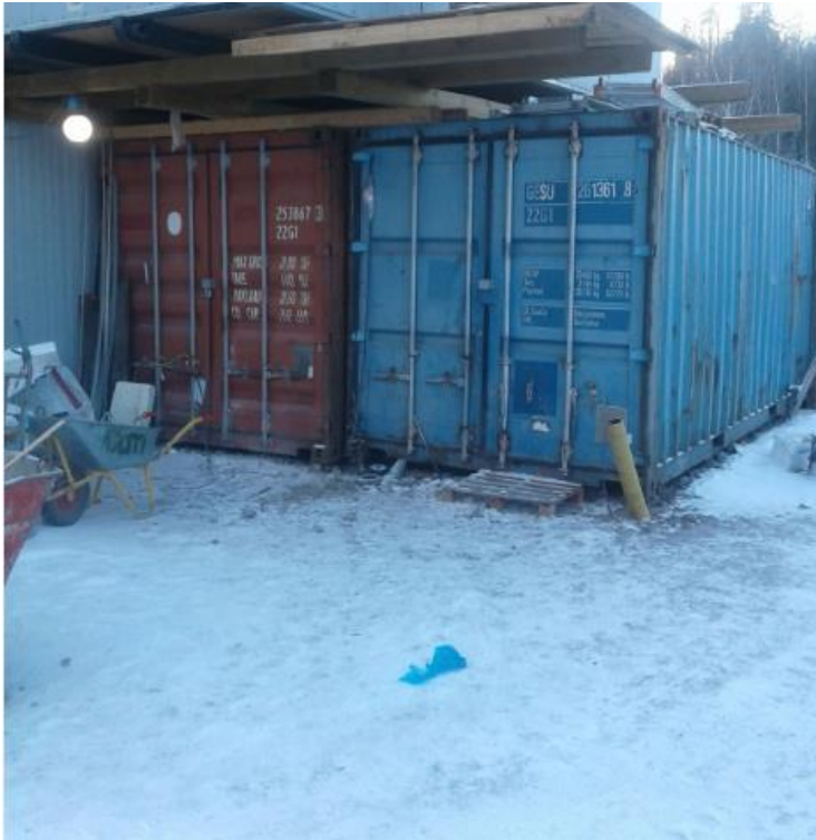
Kuva 23 Vihdin Campuksen työmaalla olevat varastokontit. Toinen konteista on lämpöeristetty ja lämmitetty lämpöpuhaltimella. (Mikael Saja)
