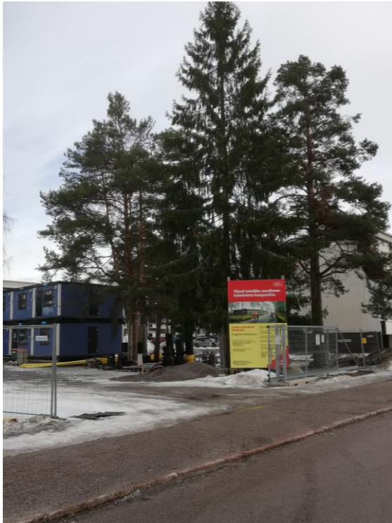
Kuva 38 LPK Neulasen työmaataulu (Mikael Saja)
