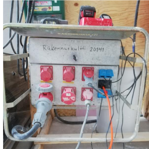
Kuva 29 Vihdin campuksella sijaitseva 63A työmaakeskus (Mikael Saja)
