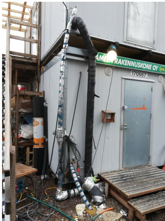
Kuva 25 Eristettyjä vesijohtoja ja viemärijohtoja (Mikael Saja)
