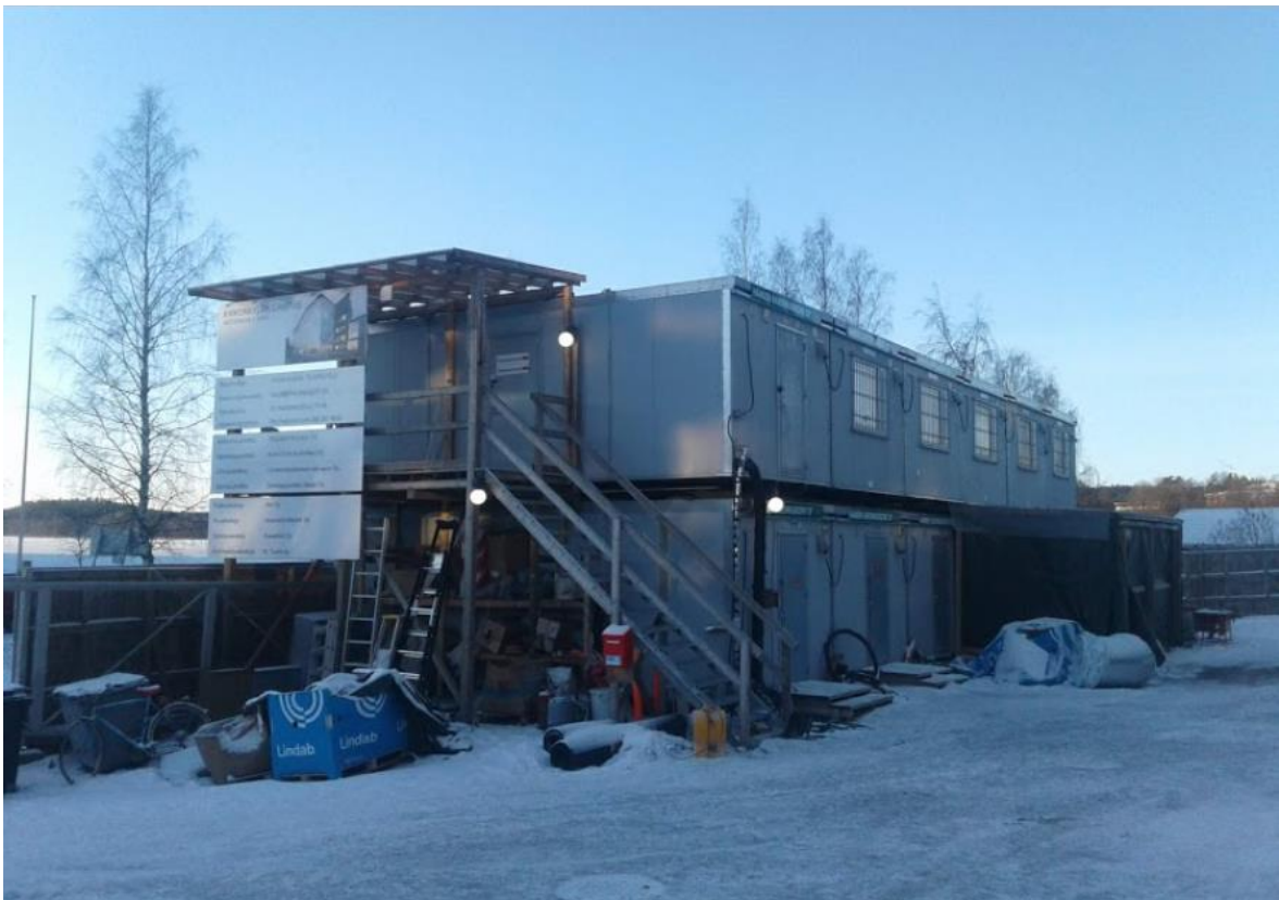
Kuva 19 Vihdin Campuksen työmaalla olevat henkilöstö- ja toimistotilat (Mikael Saja)
