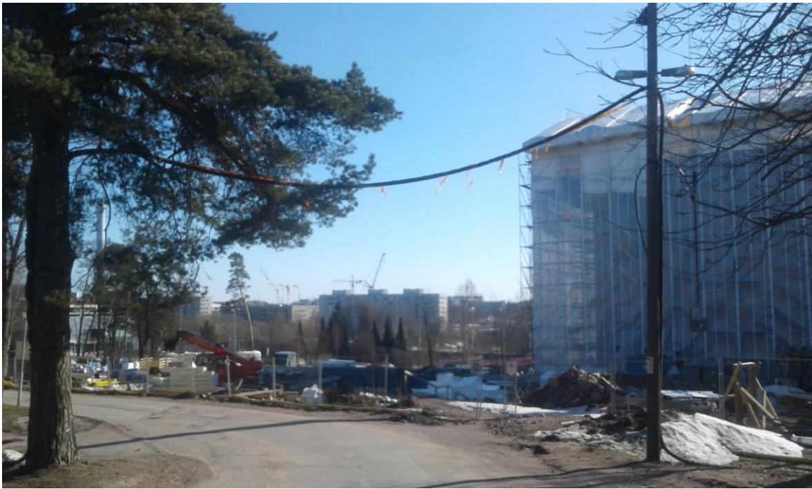
Kuva 24 Vesijohto ylittämässä tietä puun ja valopylvään kautta Keskuspuiston Ammattiosaston työmaalla (Mikael Saja)
