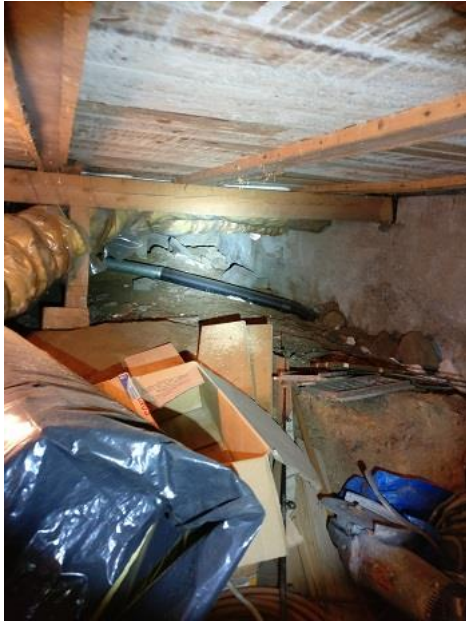
KUVA 28. Alapohjaa ja ryömintätila
