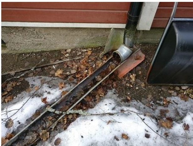
KUVA 31. Veden johtaminen pois rakennuksen vierustalta
