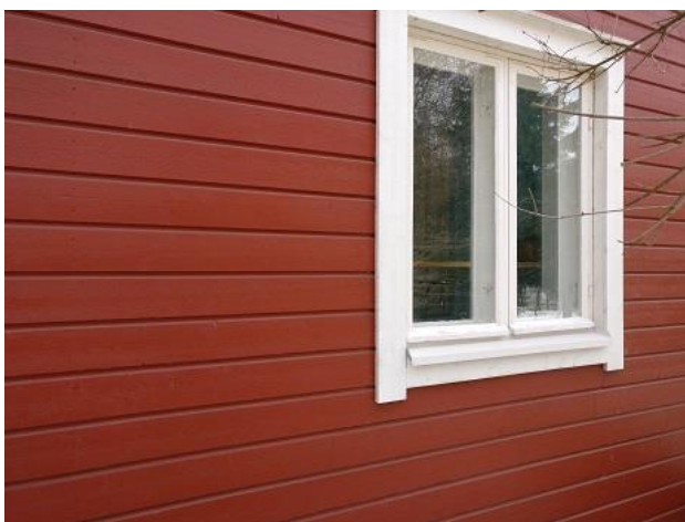
KUVA 3. Talon pohjoispuolen ikkuna ja seinää
