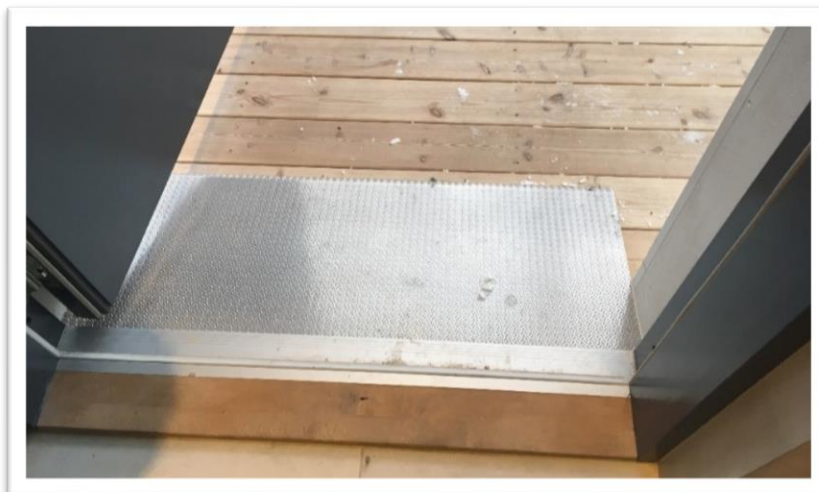
KUVA 9. Esteettömyyttä parantava leveämmin pellitetty kynnyks
