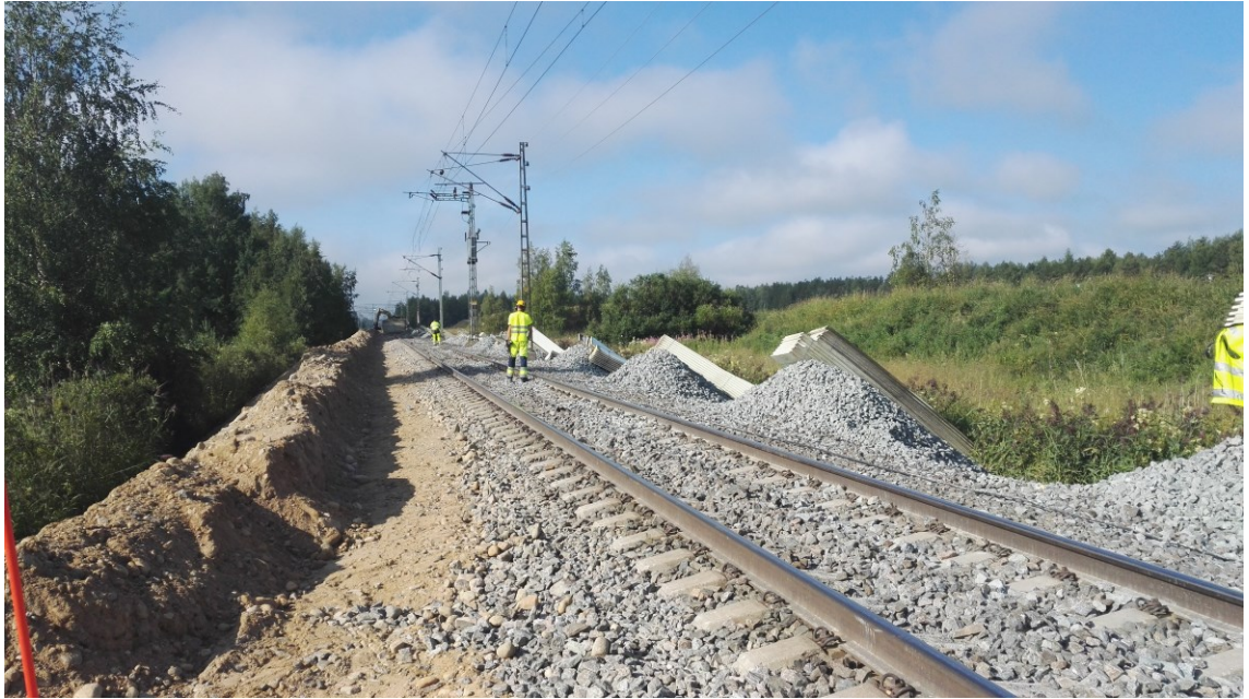
KUVA 11. Liikennekatkon valmistelutöitä, jossa ratalinjalle on tuotu eristelevyt, raidesepeleli sekä EV-sora.
