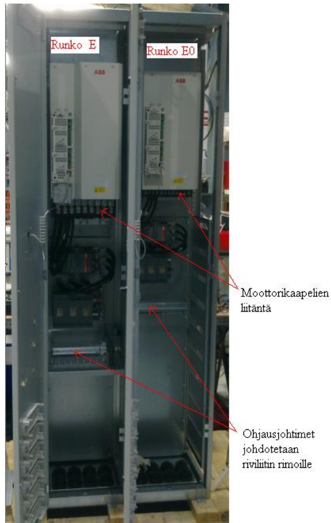
Kuva 8. Runkokokojen E0 ja E taajuusmuuttajalähtöjen sijoittelu. Kuva on kehitysvaiheessa olevasta ratkaisusta, joten sijoittelu ei ole lopullinen, mutta suuntaa antava.
